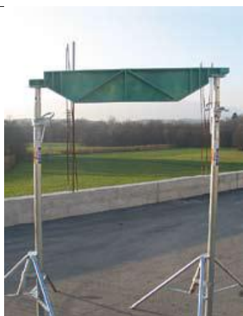
Položimo Speed na dva podpornika.
