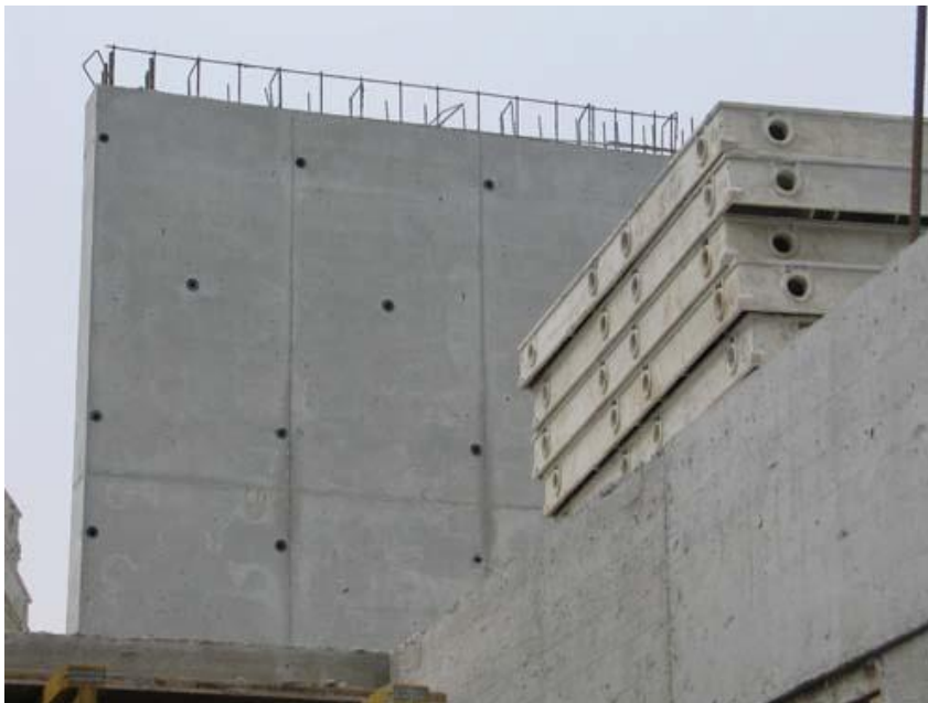
Slika 15: Površina betona, ki je bil zaopažen z Epic Ecom opažem. ( www.epic.si )
