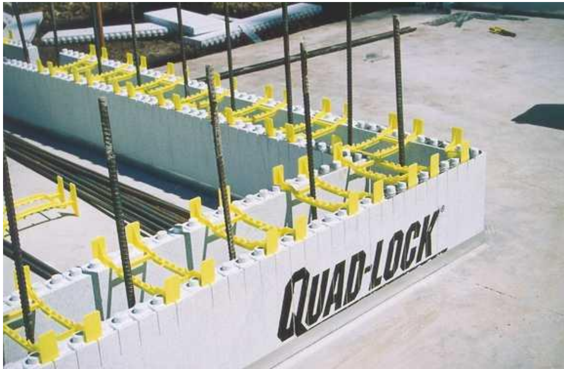
Slika 11: Izolativne betonske (cementne) forme so sistem gradnje za stanovanjske, industrijske ter ostale objekte. ( www.quadlock.com )
