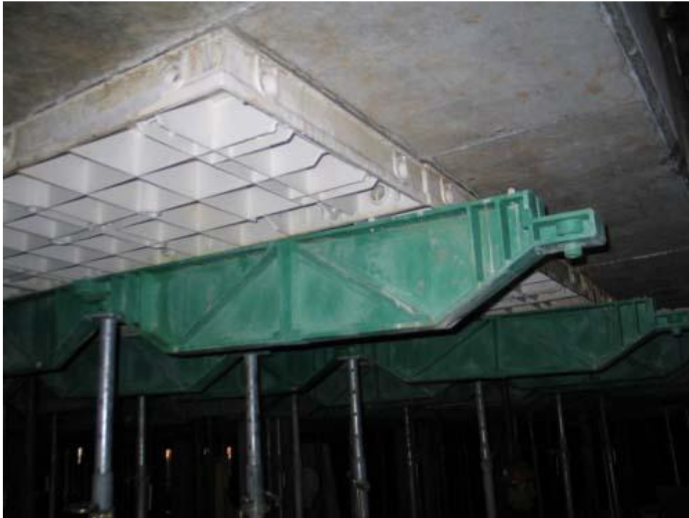
Slika 16: Stropi narejeni z opažem Epic Eco Sky Speed ( www.epic.si ).
