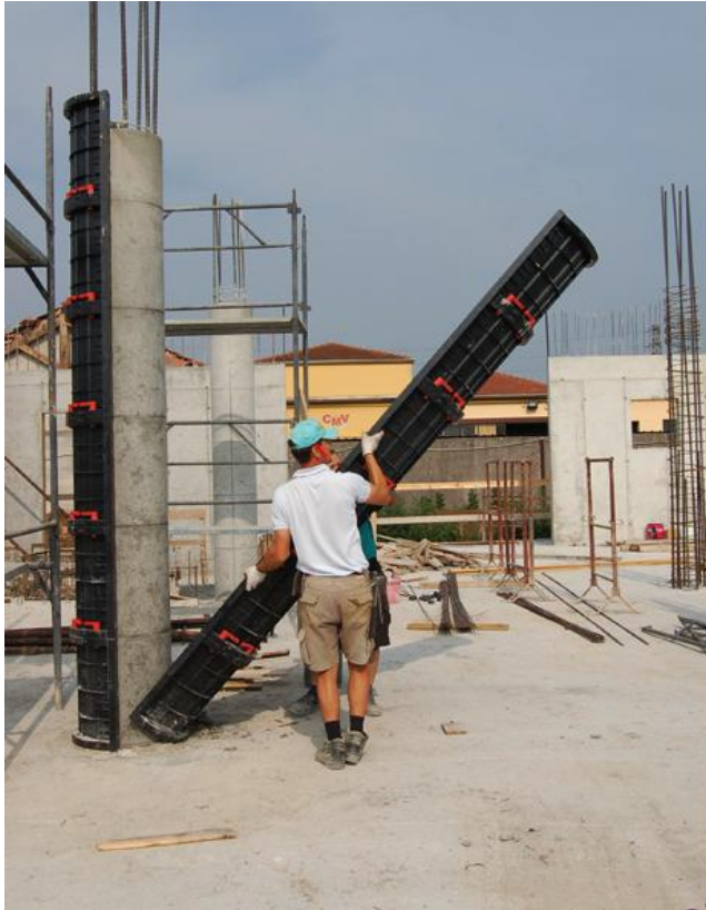
Slika 7: Kompozitni opaž za okrogle stebre. ( www.epic.si ).
