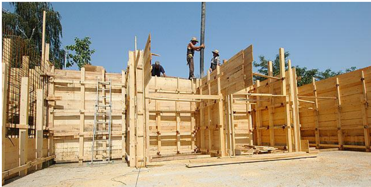
Slika 3: Postavljen tradicionalen lesen opaž za stene, nosilno vezno sredstvo so "žabice". ( http://www.beodom.com )
