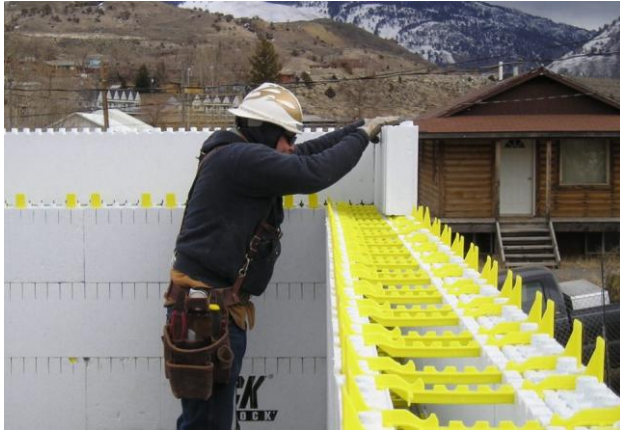
Slika 10: Sestavljanje elementov opaža, v katerega se kasneje ulije beton. ( http://www.quadlock.com )
