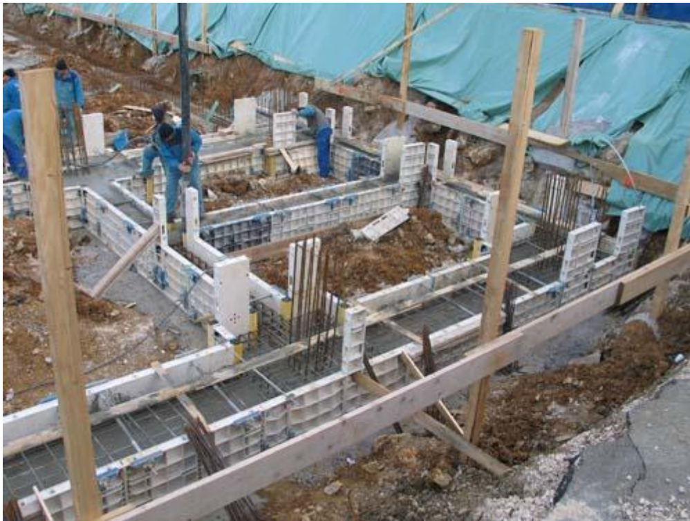
Slika 26: Betoniranje temeljev opaženih z Epic Eco sistemom. ( www.epic.si )
