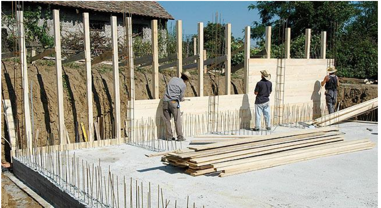
Slika 2: Gradnja opaža sten z lesenimi nosilci in deskami. ( http://www.beodom.com )
