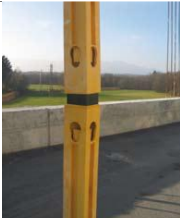
Postavitvev naslednjega vogalnika in to ponavljati do zelene višine.
