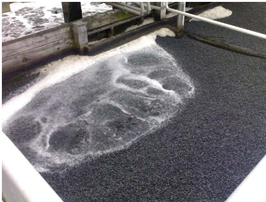
Slika 5: Nosilci biomase vstavljeni v pilotno čistilno napravo Domžale
