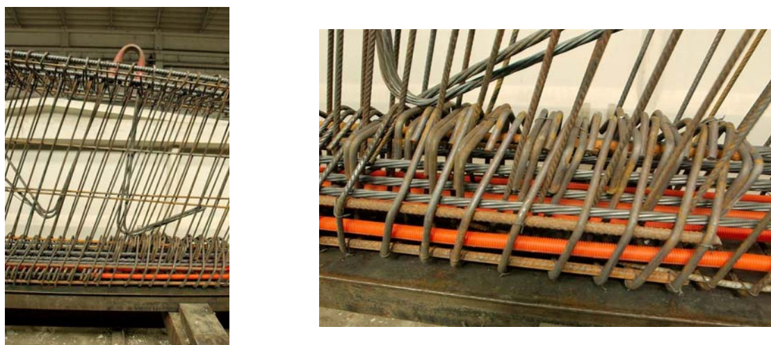
Slika 40: Prikaz nevtralizacije in sidra za dvig elementa
