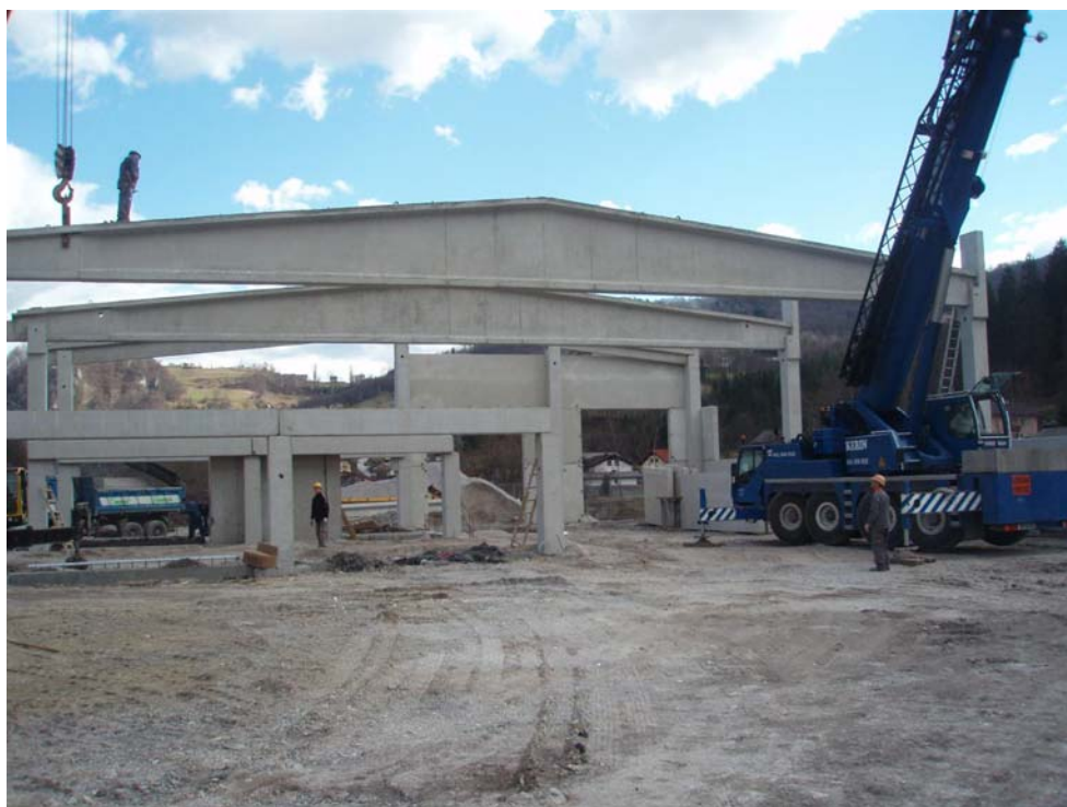
Slika 45: Montaža nosilca na gradbišču
