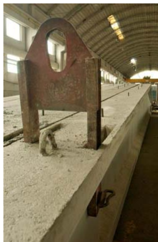
Slika 41: Dvig elementa s pomočjo posebne jeklene spojke
