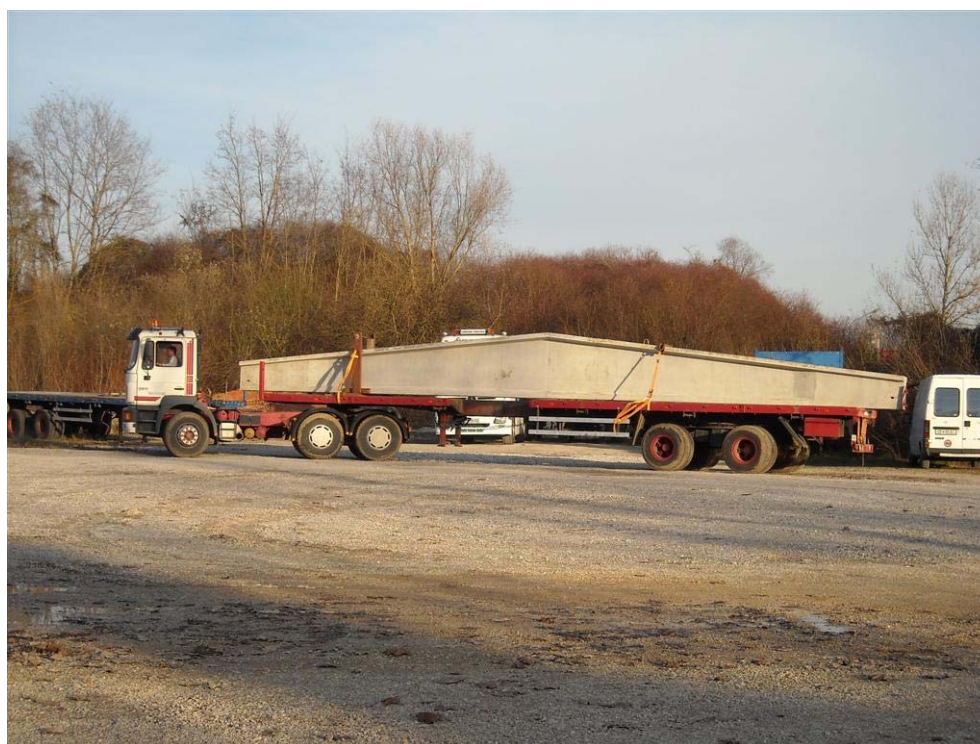
Slika 44: Transport elementa iz deponije na gradbišče
