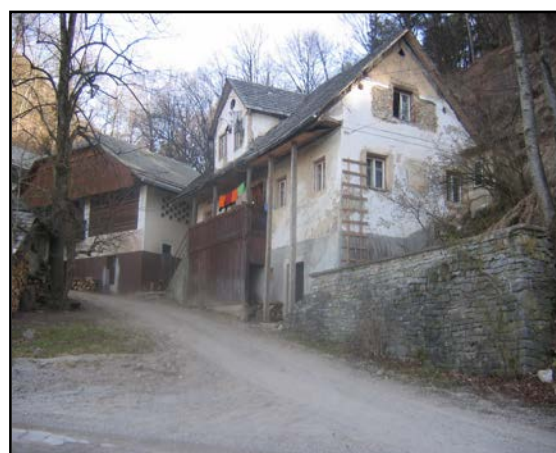
Slika 74: Prenove potrebna Fakinova hiša
