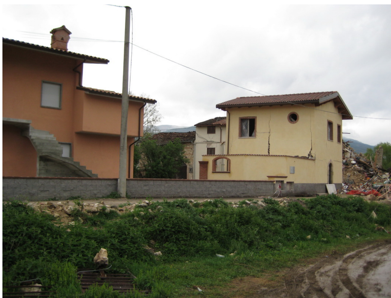
Slika 13: Različno poškodovane hiše v vasi Onna , Italija, zaradi potresa L'Aquila
