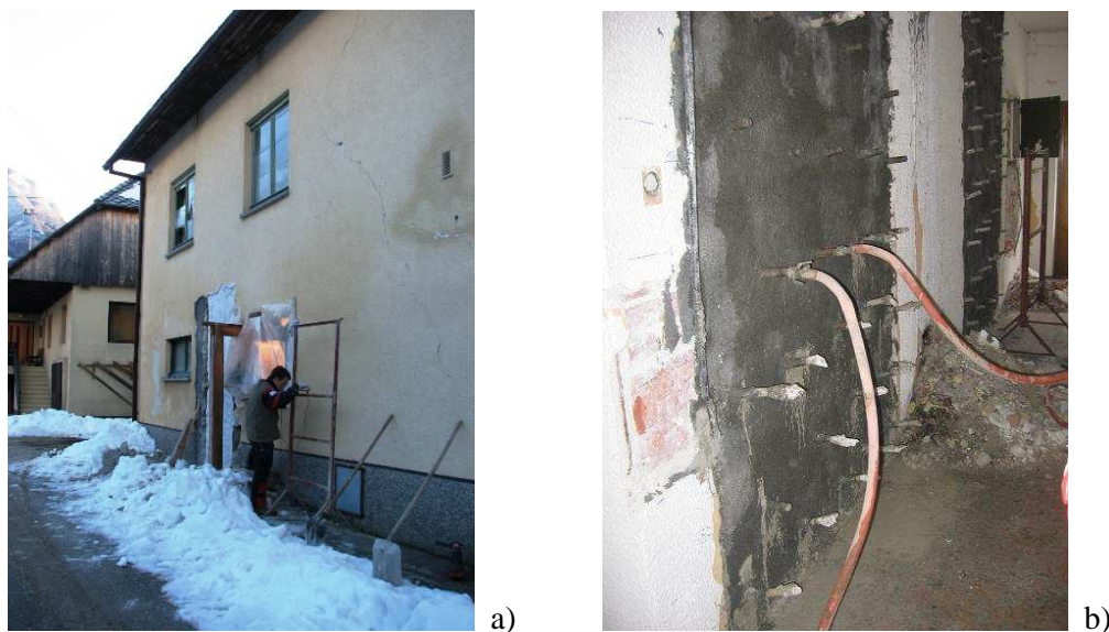
Slika 34: a) Obravnavana zidana stavba (severna stran), b) postopek injektiranja zidu
