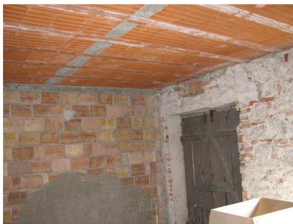
Slika 70: Opečnati monta strop obravnavane stavbe
