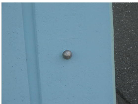
Slika 3.4: Stabilizacija reperja vzdanega v steno
