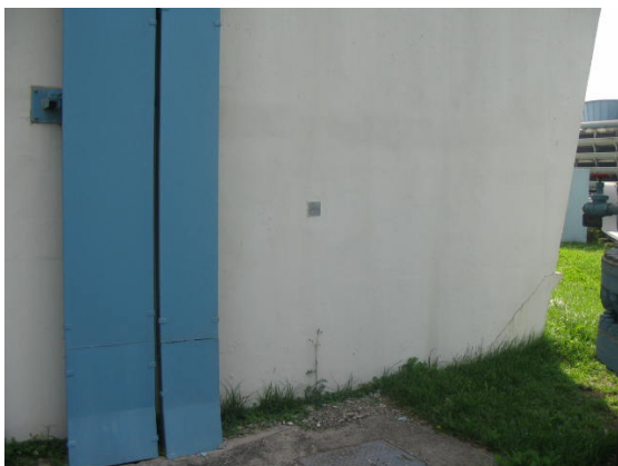
Slika 3.6: Stabilizacija reperja s kovinsko ploščo (od daleč)
