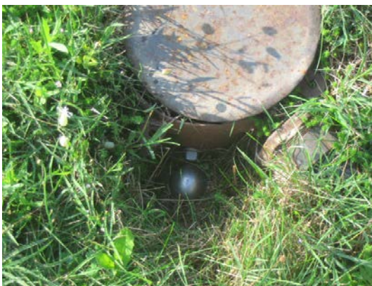
Slika 3.1: Stabilizacija reperja R100
