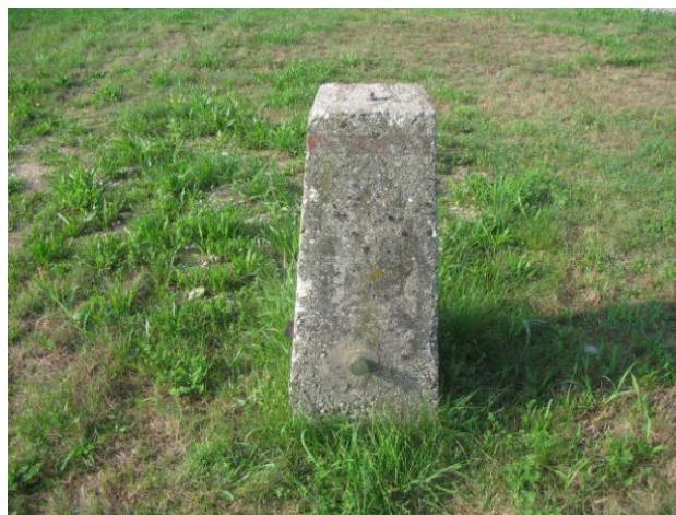
Slika 3.3: Stabilizacija reperja RIV
