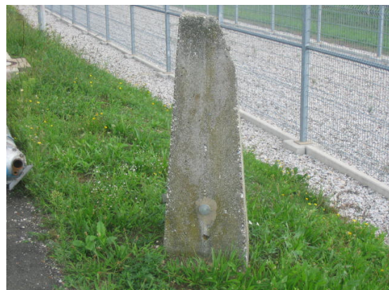
Slika 3.2: Stabilizacija reperja RII
