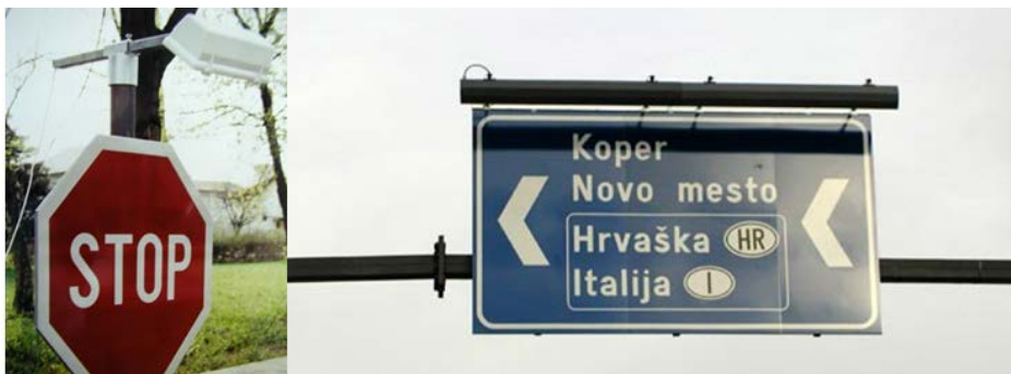
Slika 7 : Primer znaka in portalne table z zunanjo osvetlitvijo
