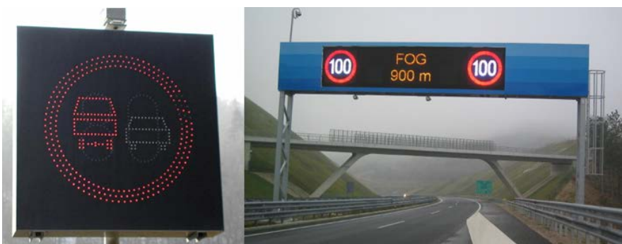
Slika 9 : Znaki delujoči z uporabo LED tehnologije
