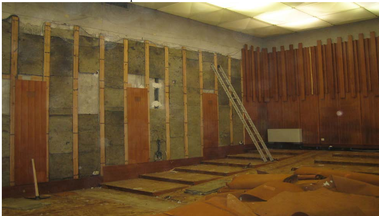
Slika št. 12: Velika dvorana med prenovo
