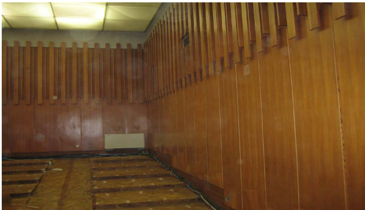
Slika št.13: Velika dvorana med prenovo
