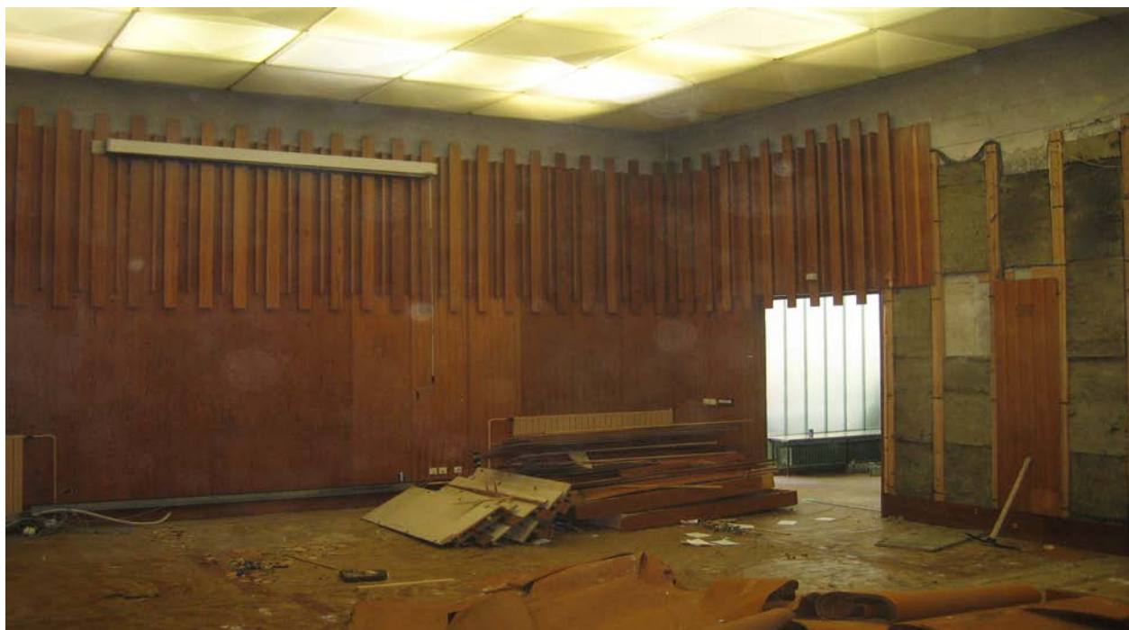
Slika št.14: Velika dvorana med prenovo
