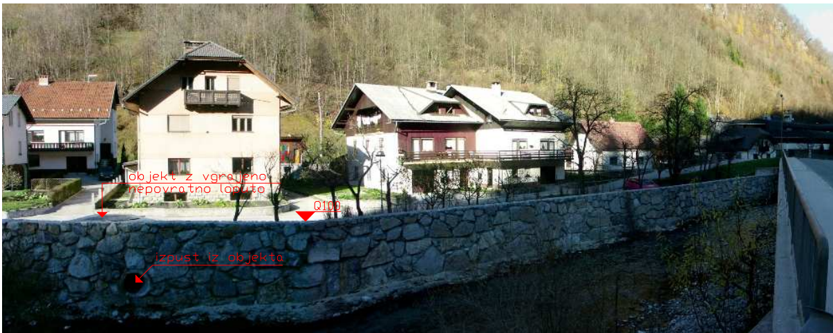
Slika 10: Nov protipoplavni zid na levem bregu gorvodno od premostitve v P36
