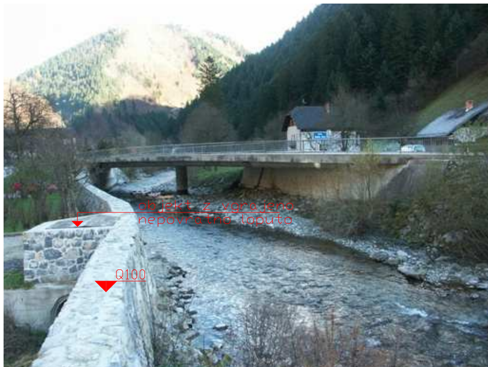
Slika 16: Premostitev z gorvodne strani in protipoplavni zid na levem bregu
