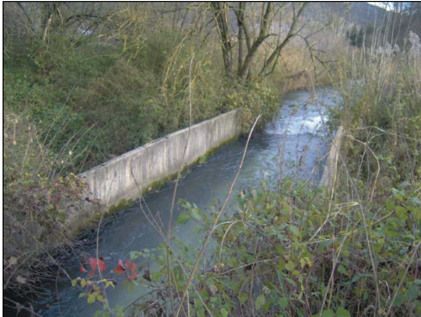
Slika 7: Akvadukt prečka izsušeno strugo.
