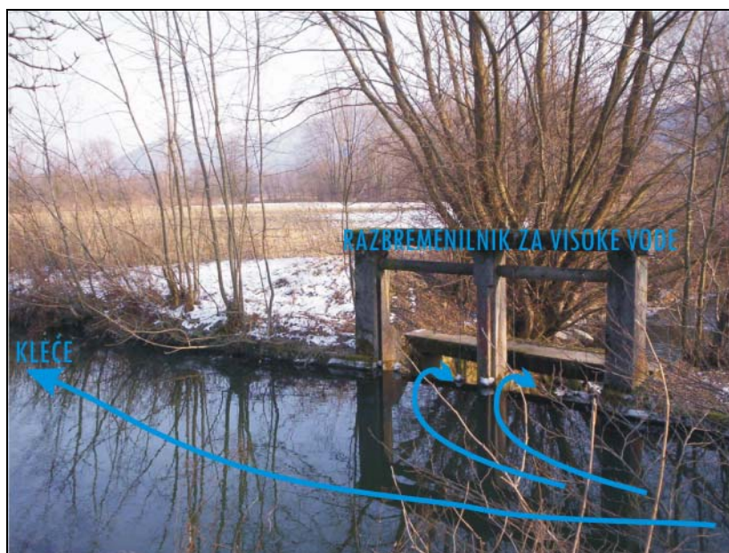
Slika 9: Bočni preliv preko tablaste zapornice pri Klečah.
