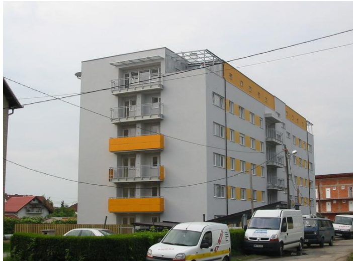
Slika 25: Prikaz stanovanjskega objekta Tezno (vir: http://www.konstruktor.si )
