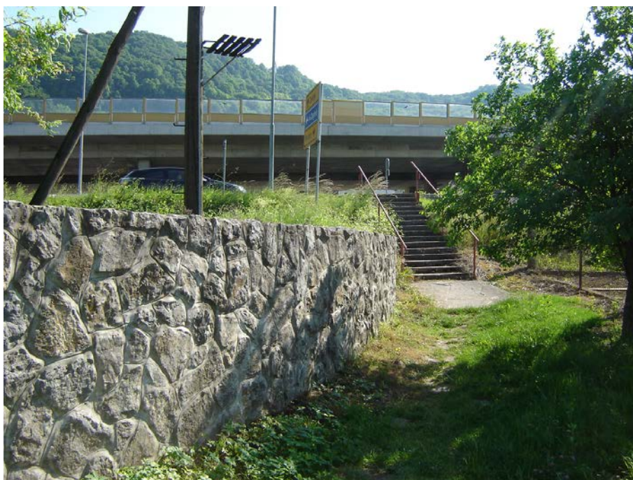
Slika 17: Začetek obstoječega zidu na desni strani reke Save za protipoplavno zaščito kraja Čatež ob Savi.
