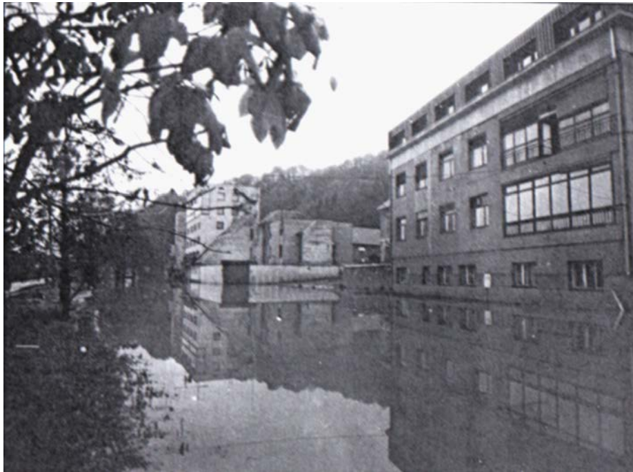
Slika 6: Visok nasip za novo cesto skozi Krško je preprečeval, da bi voda iz Dalmatinove ulice, kjer je zalila številne zgradbe, hitreje odtekla (UJMA, 1991)
