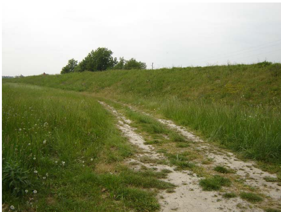
Slika 15: Zgrajeni nasip na levi strani reke Save za protipoplavno zaščito kraja Mostec.
