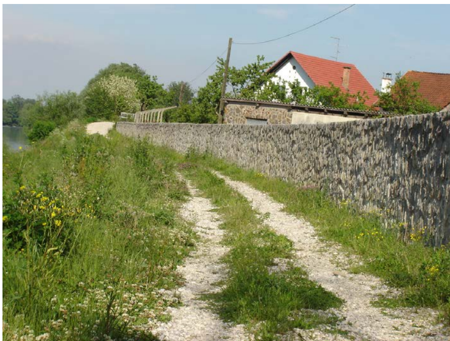
Slika 18: Konec obstoječega zidu na desni strani reke Save za protipoplavno zaščito kraja Čatež ob Savi, ki nato preide v nasip.
