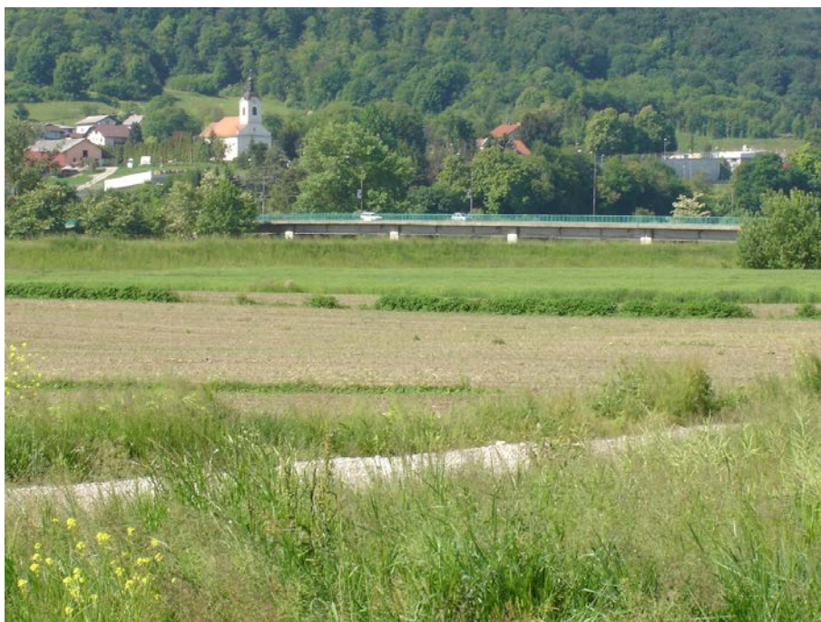
Slika 16: Zgrajeni nasip na levi strani reke Save za protipoplavno zaščito kraja Brežice.
