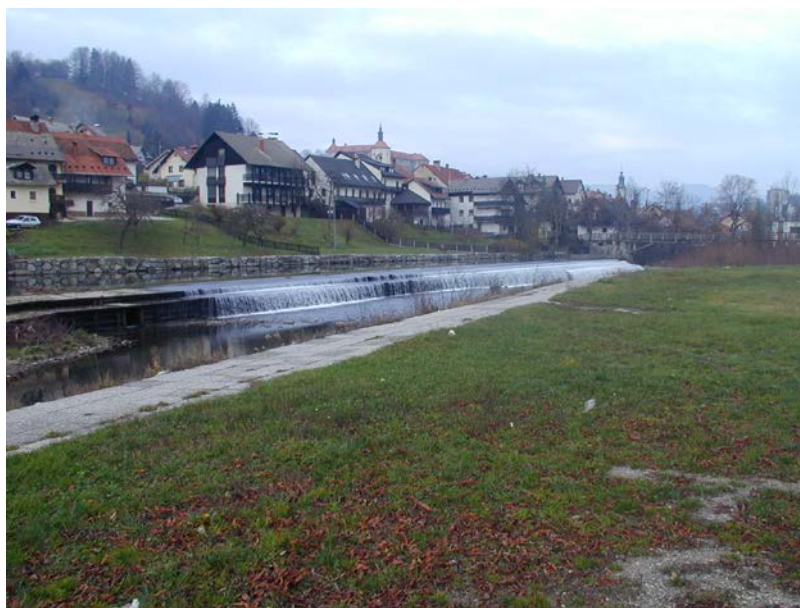
Slika 11: Dolvodni pogled iz desnega brega na Puštalski kopališki jez. Tlakovani del predstavlja krono protipoplavnega nasipa, v ozadju »hudičeva brv« preko monolitne soteske. (foto: Jeriha, 2007)
