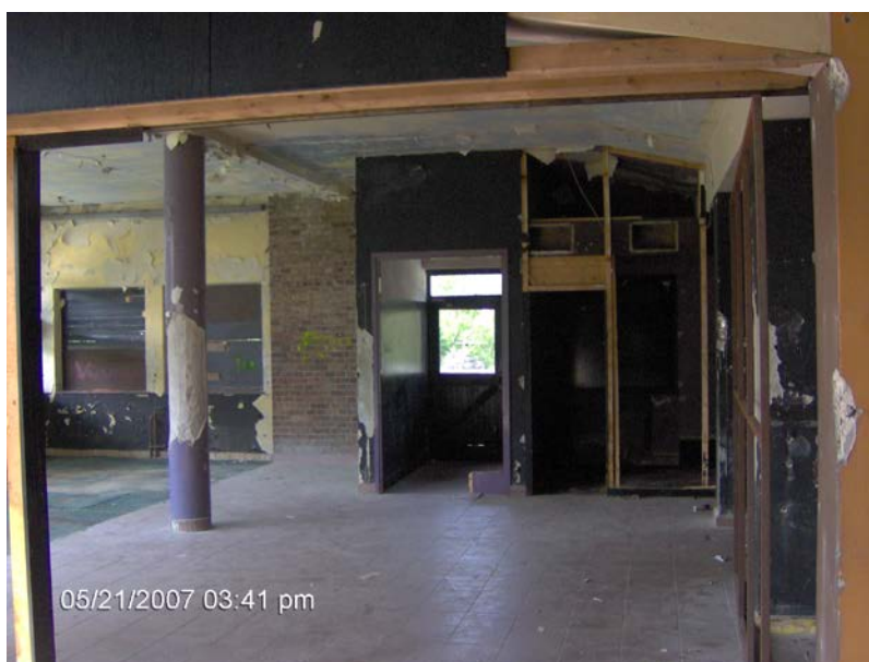
Slika 6: Notranjost severnega dela zgornje etaže, ki je v celoti nad gladino 100 letne vode. Prostor je konstrukcijsko v solidnem stanju, stavbna oprema zaradi vandalizma uničena.(foto: Jeriha, 2007)
