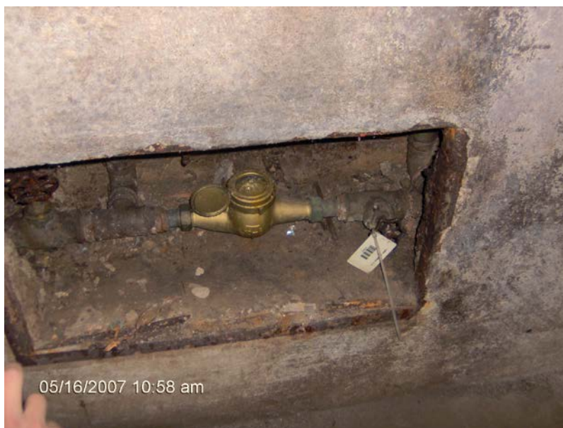
Slika 20: Nezaščiten obstoječi vodomer, višinsko situiran cca 1,95 m pod gladino 100 letne vode.(Foto: Jeriha, 2007)
