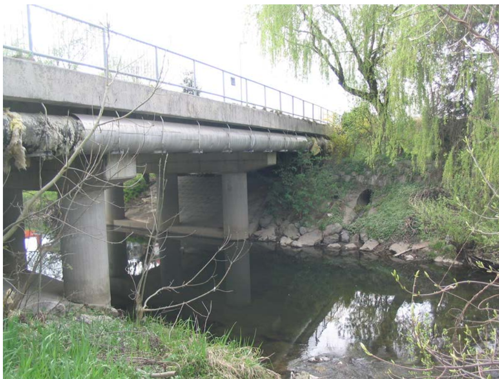
Slika 3.16: Most na Hladnikovi cesti, pogled gorvodno (foto: Jamnik, april 2007).
