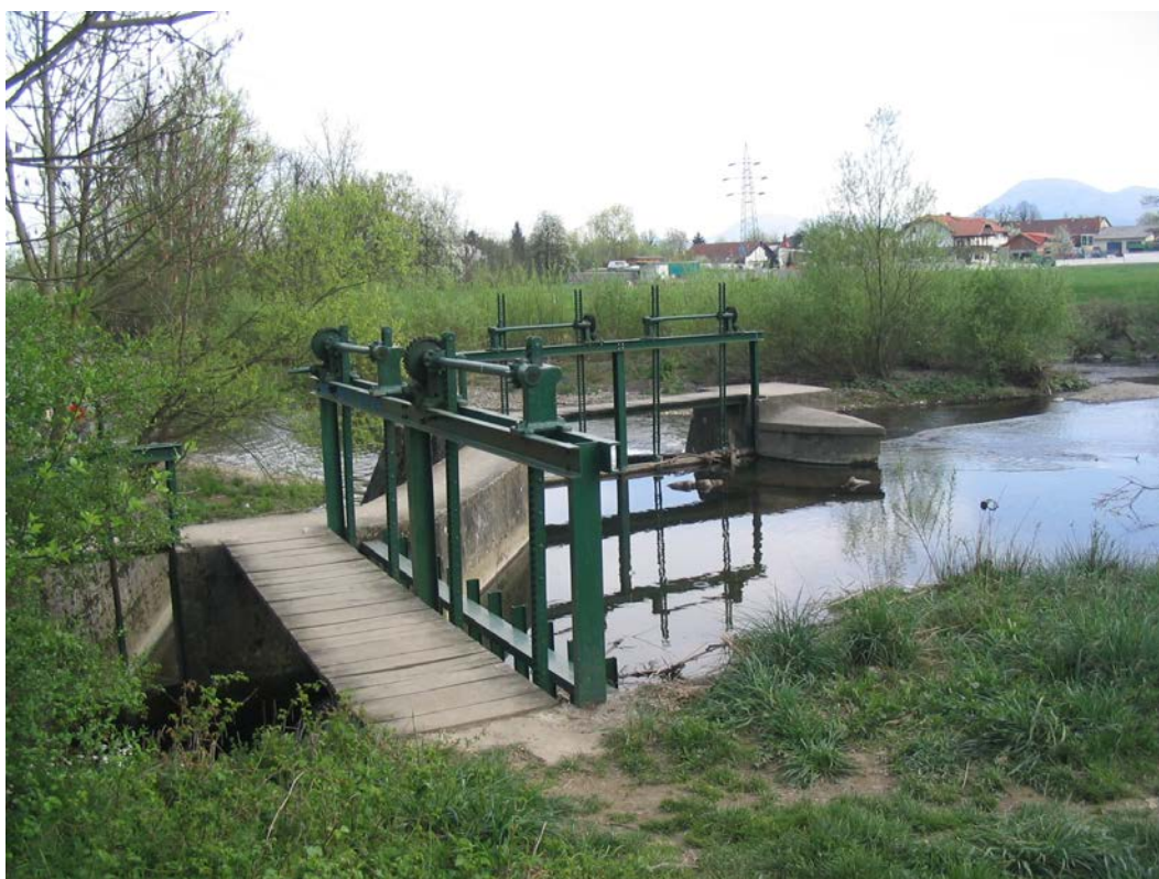
Slika 3.10: Zapornice na Bokalškem jezu, za Mestno Gradaščico (spredaj) in za Mali graben (zadaj) (foto: Jamnik, april 2007).
