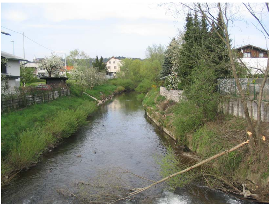
Slika 3.7: Slika z mostu na Opekarski cesti dolvodno. Naselje zelo blizu vodotoka.
