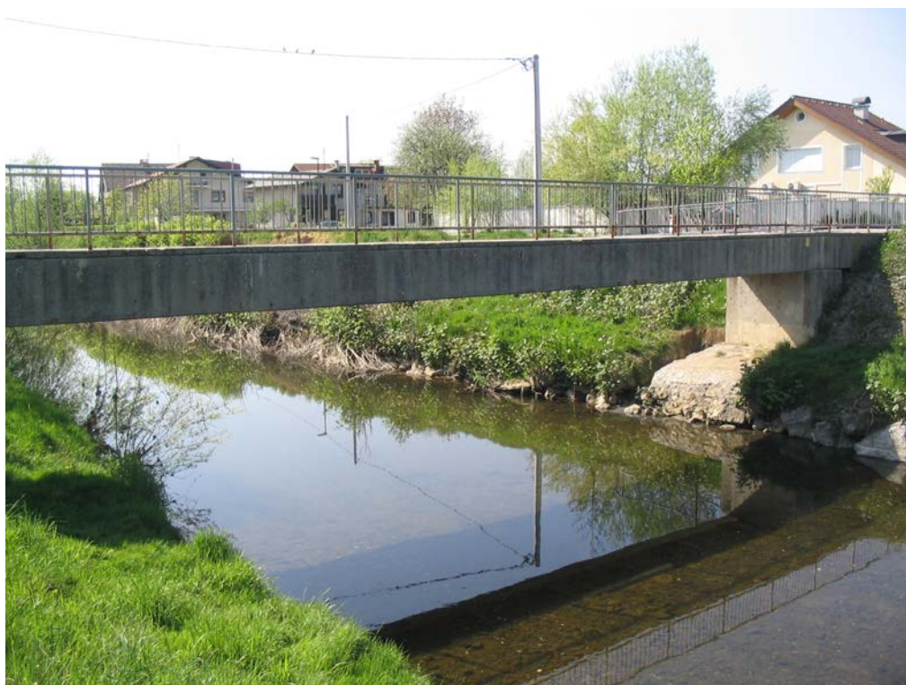
Slika 3.13: Most na Mokrški ulici. Pogled gorvodno (foto: Jamnik, april 2007).
