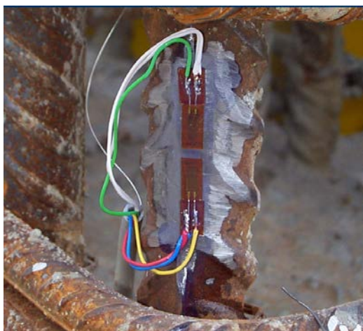
Slika 35: Merilni listič, pritrjen na armaturi
