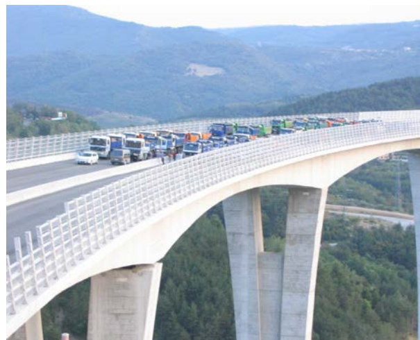
Slika 2: Primer postavitve tovornjakov med obremenilno preizkušnjo
