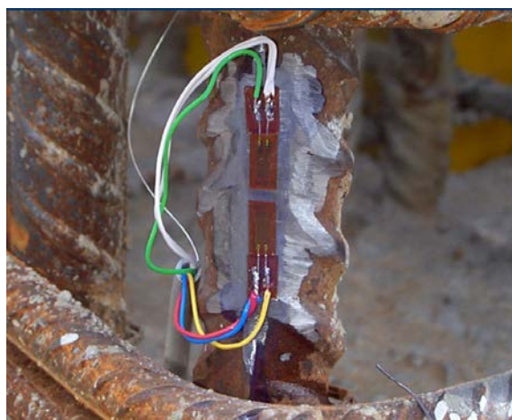
Slika 52 : Merilni listič na armaturi
