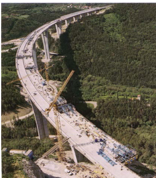
Slika 45: Gradnja viadukta Črni Kal [Pipenbaher, 2004]
