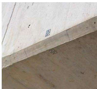
Slika 57: Refleksijska tarča nalepljena na spodnjo stran viadukta
