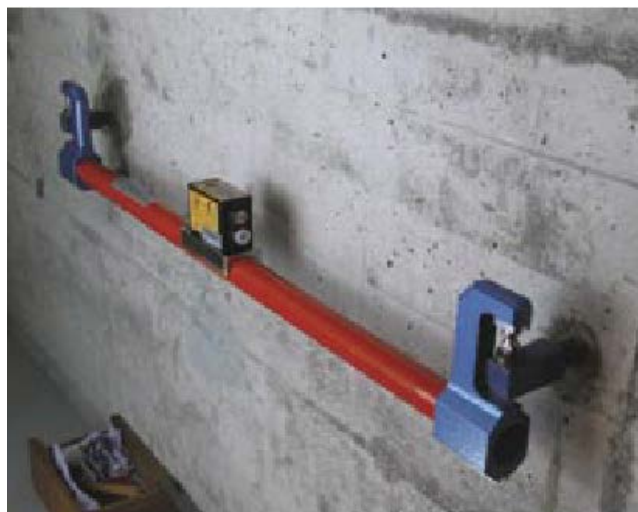
Slika 43: Klinometer pritrjen na steno objekta
