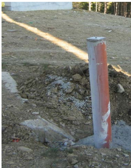
Slika 60: Armirani betonski steber z navojno ploščo
