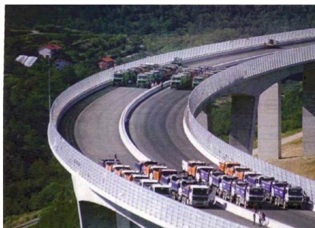
Slika 62: Postavitev tovornjakov med obtežno fazo 17
