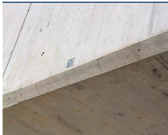
Slika 24: Refleksijske tarče nalepljene na viaduktu
