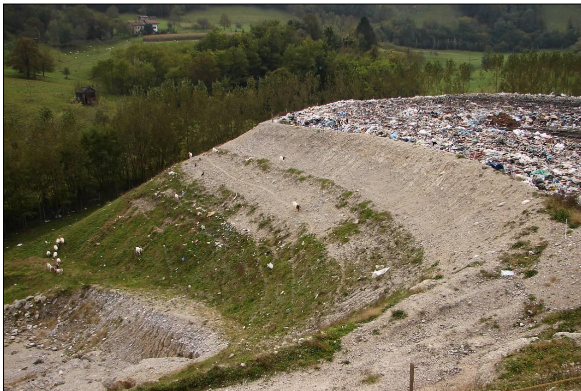
Slika 7: Prikaz sprotne izgradnje brežine aktivnega polja odlagališča
