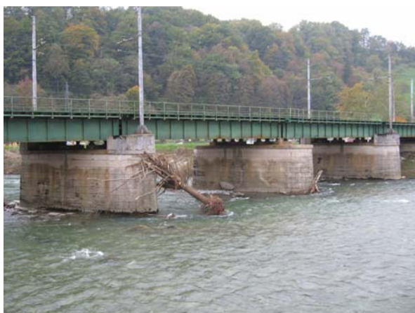
Slika 21, deblo, zagozdeno za mostni opornik
