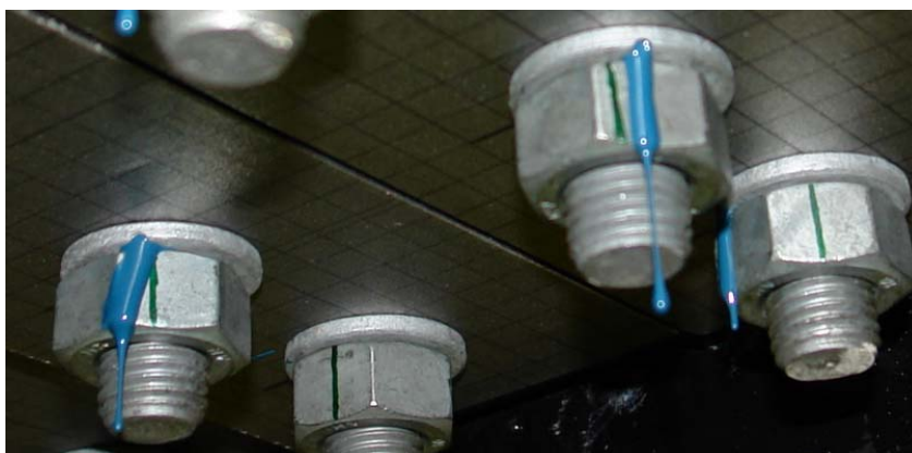
Slika 3.7: Uhajanje smole iz vijakov po injektiranju
