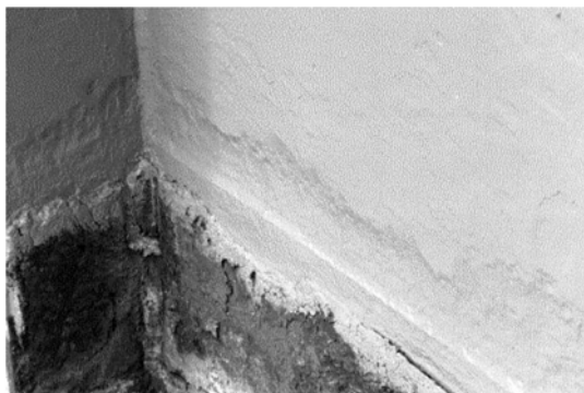
Vzorec korozije na nivoju voziščne konstrukcije (INJECTION BOLTS TO REPAIR OLD BRIDGES, str. 37).
