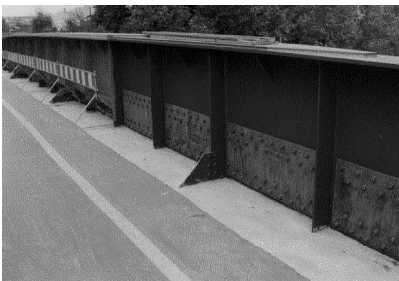
Injektiranje v izdelavi (levo) in pogled na ojačitve glavnega nosilca (desno). (INJECTION BOLTS TO REPAIR OLD BRIDGES, str. 37).
