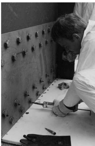
Injektiranje v izdelavi (levo) in pogled na ojačitve glavnega nosilca (desno). (INJECTION BOLTS TO REPAIR OLD BRIDGES, str. 37).
