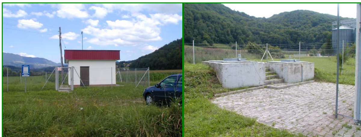
Slika 19: Vodni vir Šmartno ob Paki ( levo ) in vodnjaka na vodnem viru Rečica 1 ( desno )
