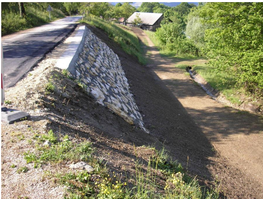
Slika 27: Sanacija zemeljskega plazu na JP Okroglice – Lovrenc (občina Sevnica – g. Joško Žvar)
