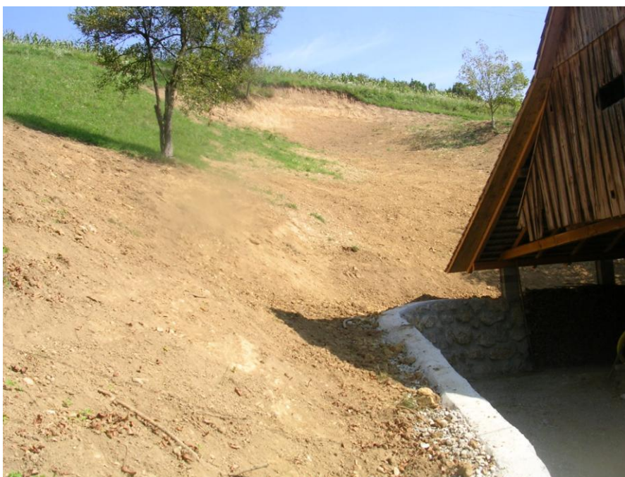
Slika 32: Sanacija zemeljskega plazu nad gospodarskim objektom Avgusta Radiča (občina Sevnica – g. Joško Žvar)
