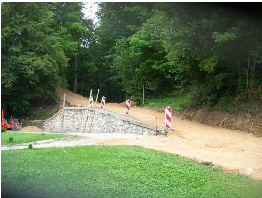
Slika 25: Sanacija lokalne ceste Blanca - Krajna Brda (občina Sevnica – g. Joško Žvar)
