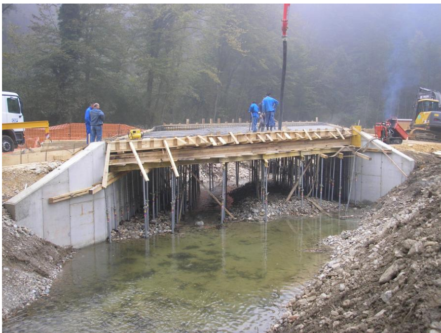
Slika 23: Izdelava novega mostu čez potok Blanščica na LC Blanca – Poklek (občina Sevnica – g. Joško Žvar)
