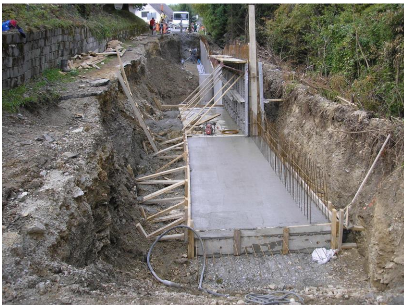
Slika 24: Sanacija zemeljskega plazu na LC Dol – Zabukovje; pod cerkvijo Sv.Lenarta (občina Sevnica – g. Joško Žvar)
