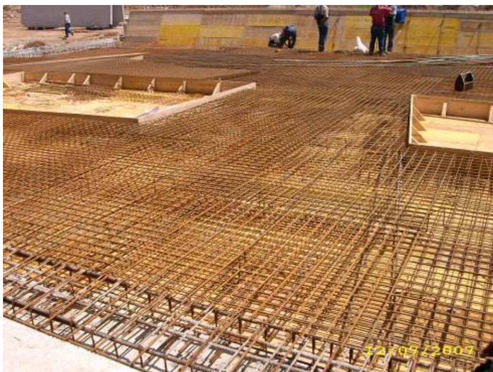
Slika 11: Vgrajena armatura
