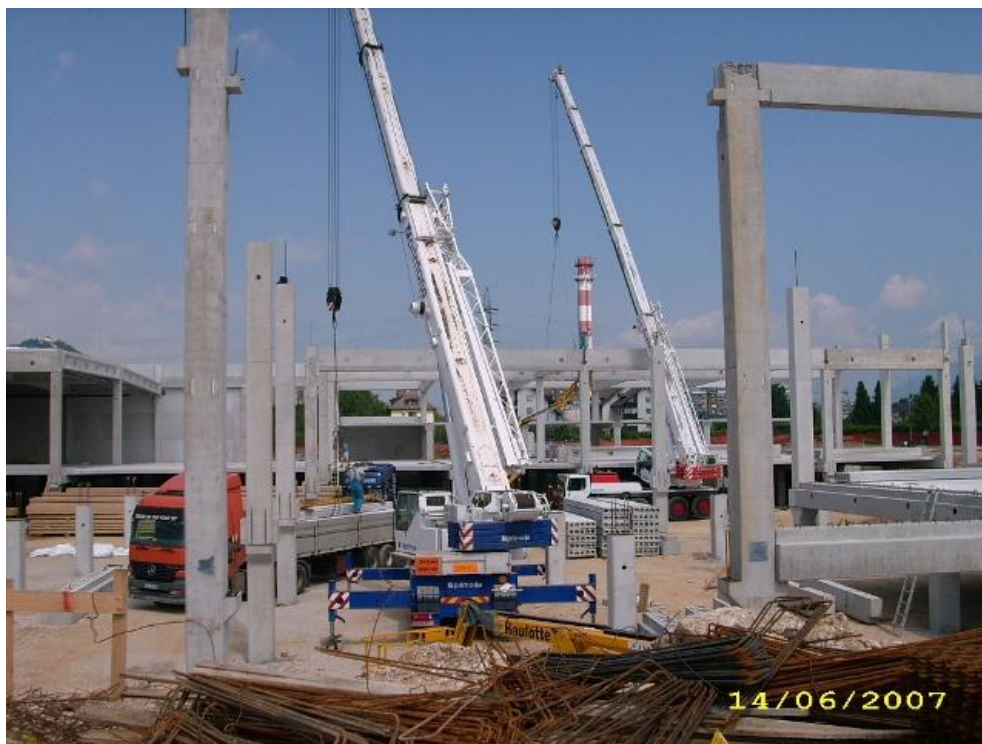
Slika 8: Montažna gradnja trgovskega centra Qlandia
