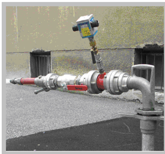
Slika 26: Merilnik postavljen na hidrant
