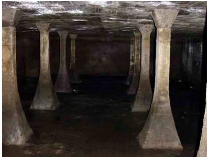
Slika 51: Notranjost cisterne C6 v parku
