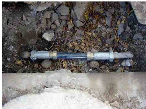
Slika 59: Popravilo poškodovane cevi
