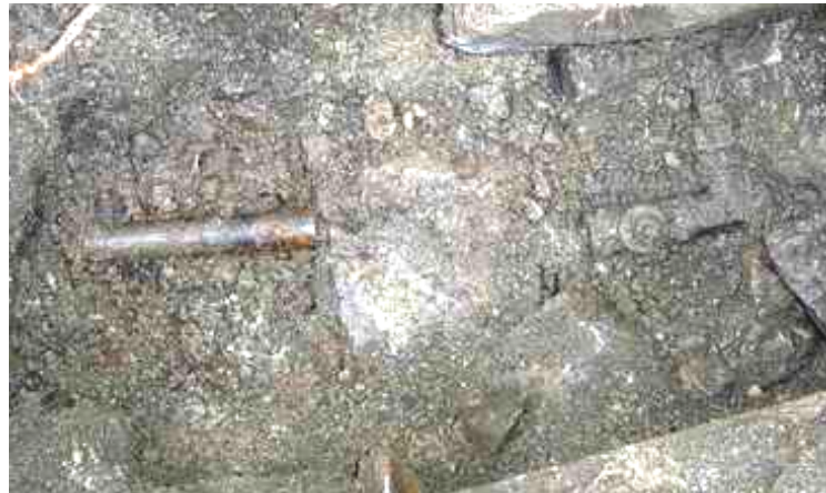
Slika 56: Pretrgana cev, sekcijski ventil in odcep za napajalno korito
