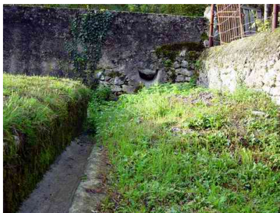
Slika 40: Vhod koritnice s severne strani hriba v zaraščen usedalnik
