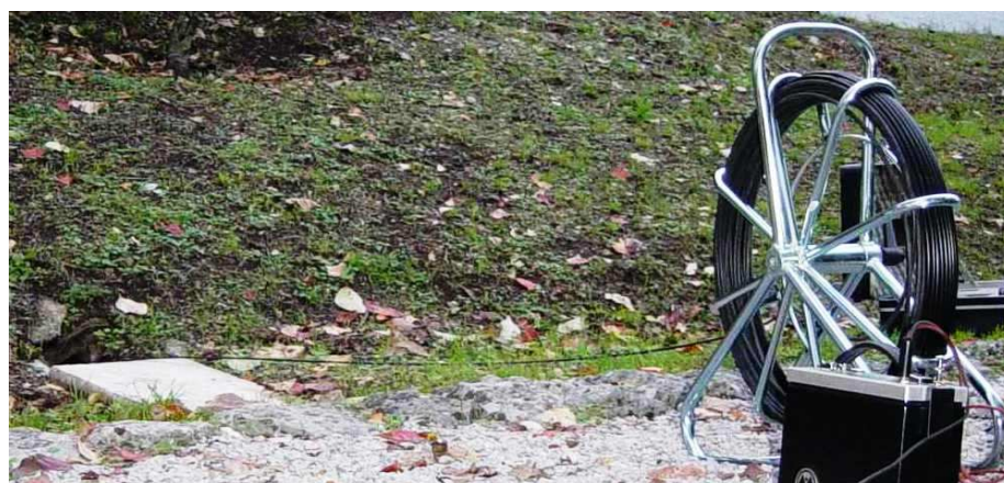
Slika 16: Uvlačenje vodnika v betonsko kineto v parku pod pergolo
