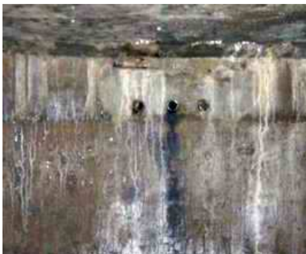
Slika 49: Tri dotočne pocinkane cevi \phi 1''
