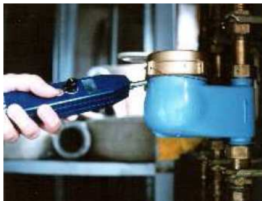
Slika 29: Preiskovanje tesnosti hišnega priključka (Andotehna d.o.o., 2005)
