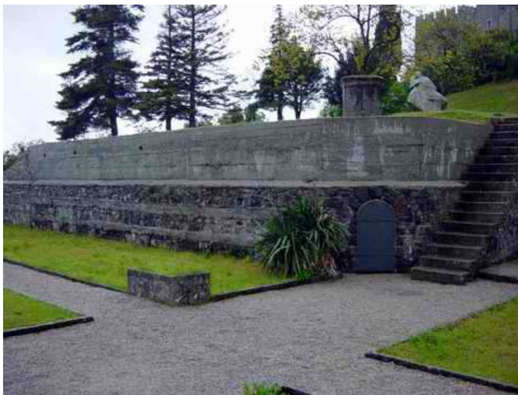
Slika 48: Vzhodni del cisterne C6 v parku, z vhodnim jaškom in iztočno nišo
