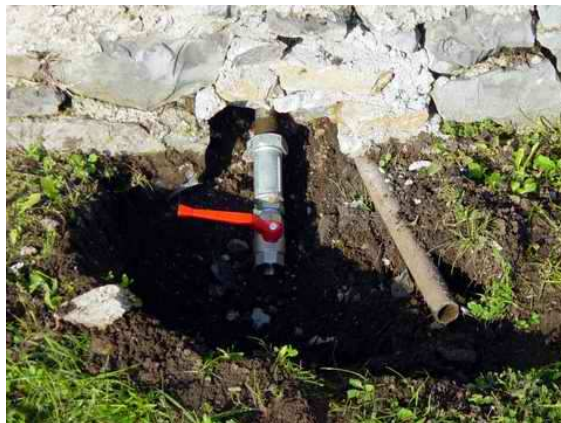
Slika 61: Vgradnja krogličnega ventila
