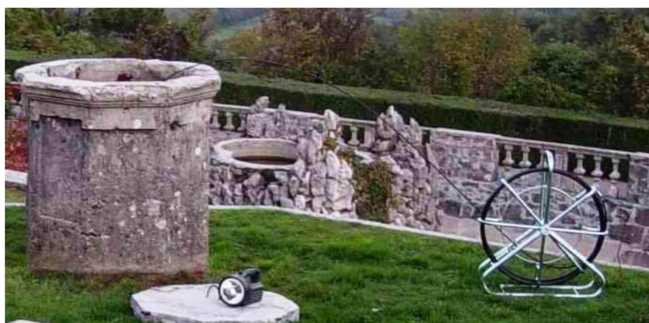
Slika 15: Uvlačenje vodnika v betonsko cev, ki vodi v cisterno C6 (v parku)
