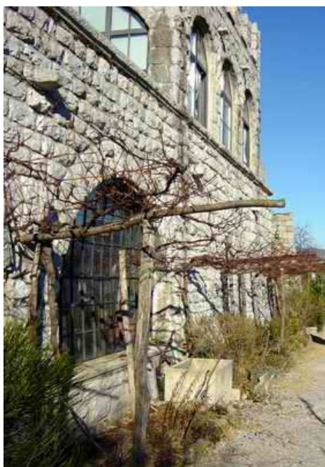
Slika 45: Cisterna C3 pod teraso vile Ferrari
