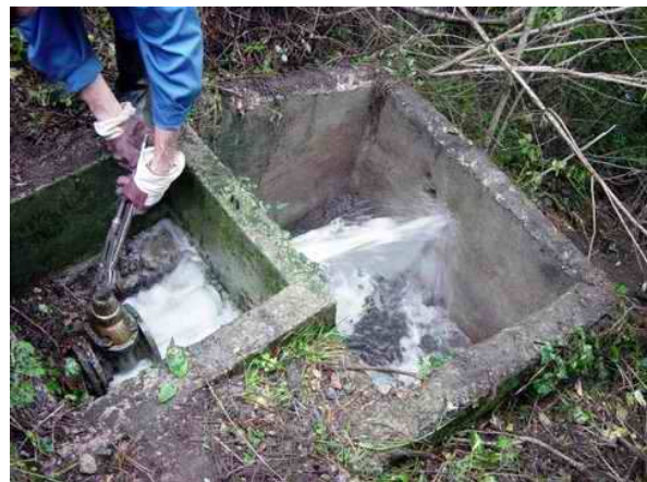
Slika 67: Jašek z ventilom za talni izpust
