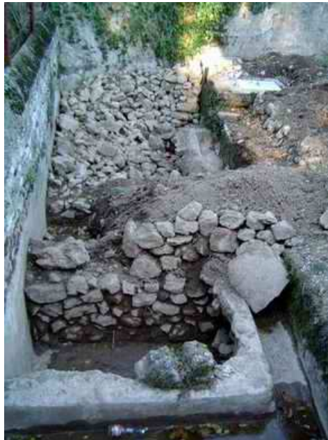
Slika 41: Delno odkopan usedalnik za čiščenje deževnice s hriba
