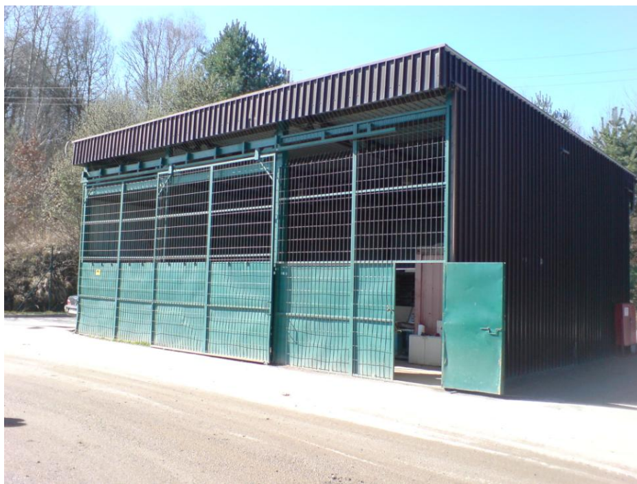
Slika 5: Začasno montažno skladišče za nevarne odpadke
