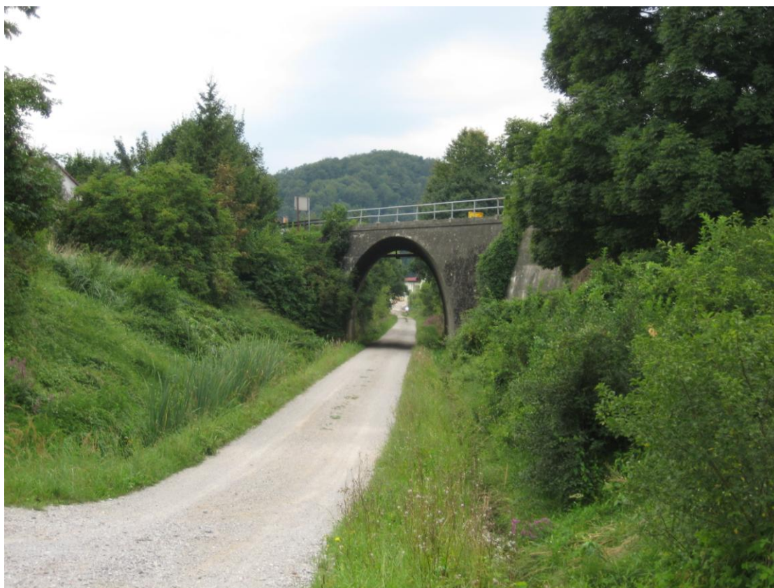
Slika 22: Obstoječi nadvoz ceste (del stare železniške proge), ki bi ga bilo možno v primeru podaljška mestne železnice uporabiti kot del trase.
