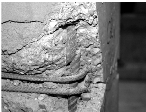
Slika 2.19: Pretrg vzdolžne armature zaradi povečane razdalje med stremeni Figure 2.19: Failure of a longitudinal bar due to increased stirrup spacing
