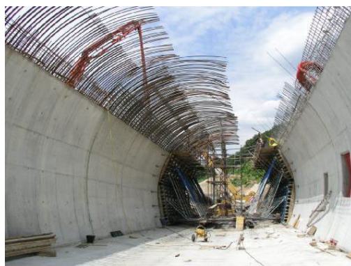
Slika 2.8: Primer uporabe SCC za močno armirano konstrukcijo »Pokriti vkop na HC Razdrto – Vipava«
