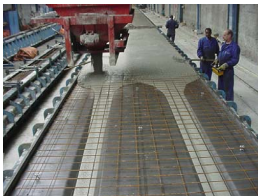
Slika 1.1: Primer vgrajevanja SCC (The European Guidelines..., 2005)
