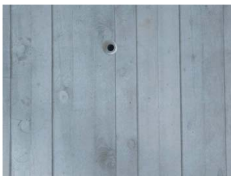
Slika 2.3: SCC popolnoma prevzame strukturo površine opaža Fig. 2.3: An example of excellent filling ability of SCC
