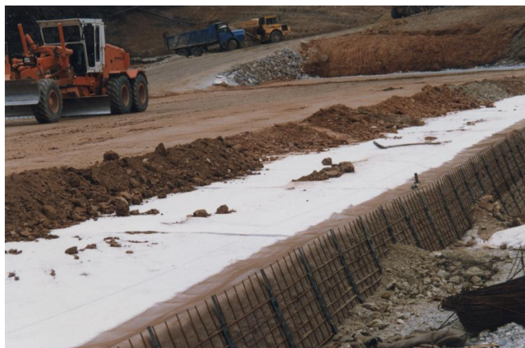
Slika 5.26 Vgrajevanje nasipnega materiala v nasip iz armirane zemljine
