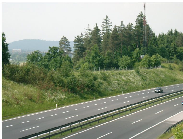
Slika 5.38 Končni izgled protihrupnega nasipa na območju profilov P56 do P60 (pogled iz AC)
