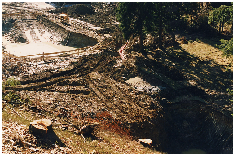
Slika 5.12 Po prekinitvi del se je v izvedenem sondažnem izkopu temeljne pete za nasip na območju profilov P100 do P114 vzpostavil naravni nivo podtalnice
