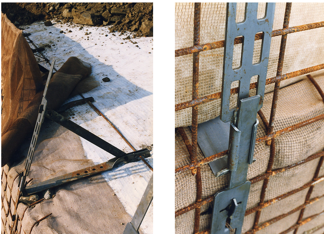
Slika 5.25 Konstrukcija nasipa iz armirane zemljine na območju brežine po tehnologiji Geomur
