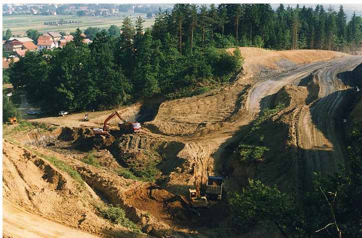
Slika 5.8 Izkop slabo nosilnih temeljnih tal pod nasipom na območju profilov P56 do P60
