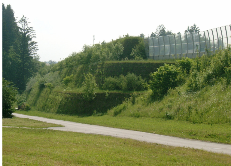
Slika 5.36 Končni izgled brežine nasipa iz armirane zemljine na območju profilov P31 do P44
