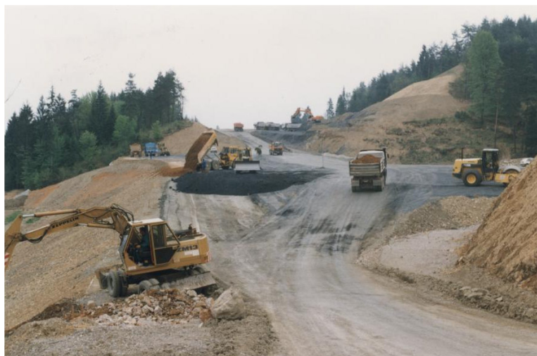
Slika 5.24 Prikaz vgrajevanja različnih materialov, pridobljenih iz vkopov, v nasip
