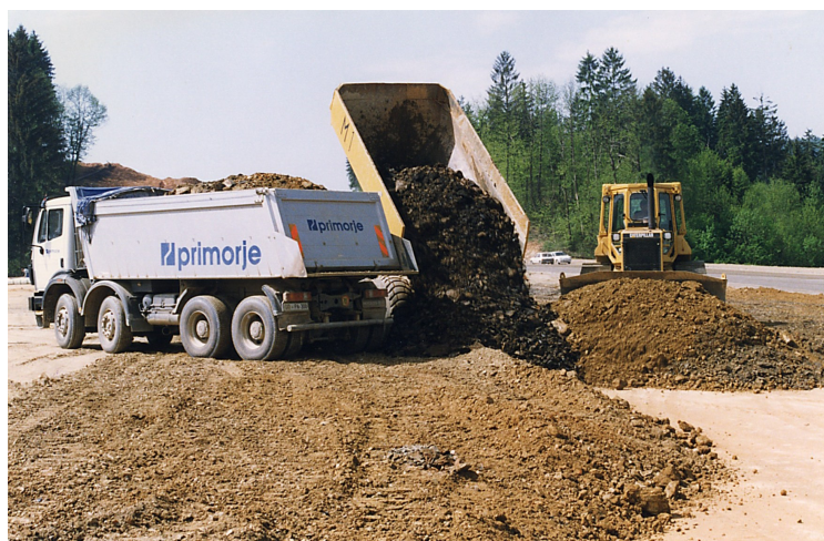
Slika 5.23 Različne materiale, ki so bili vgrajevani v nasipe, se je pri vgrajevanju med sabo mešalo Fig. 5.23 Different materials placed into embankments have been mixed
