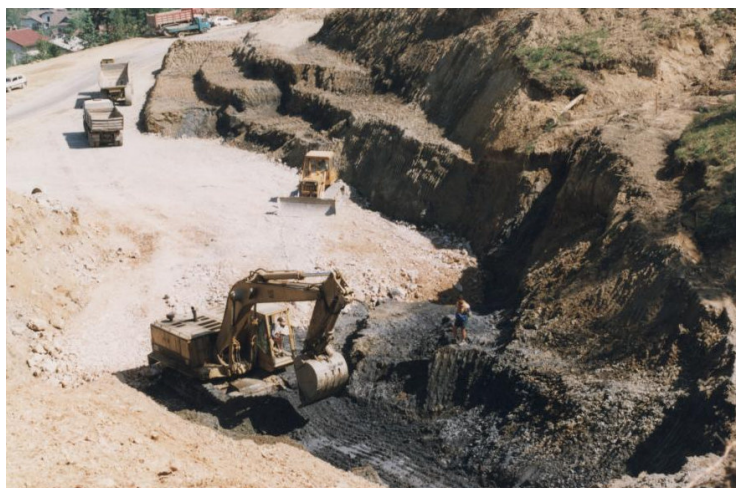
Slika 5.21 Prikaz izvedbe stopničenja v kvaliteten pobočni material in vgrajevanja zvezne drenažne preproge na stiku med temeljnimi tlemi pobočja in nasipnim materialom
