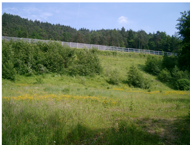
Slika 5.42 Končni izgled vzhodne brežine nasipa na območju profilov P93 do P95 (pogled iz naselja Bizovik)
