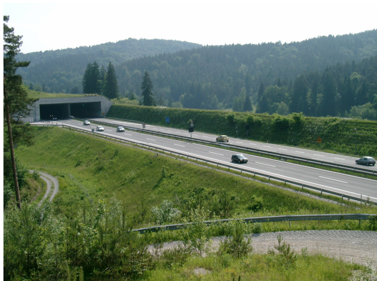
Slika 5.41 Končni izgled zahodne brežine nasipa na območju profilov P70 do P80 (pogled proti naselju Bizovik)
