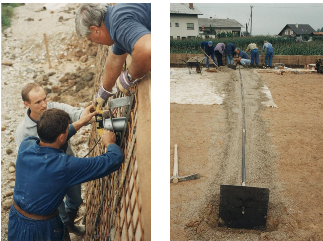
Slika 5.27 Prikaz vgrajevanja merilnikov horizontalnih relativnih premikov: na levi sliki je prikazano vgrajevanje merilne glave, na desni sliki pa so prikazane sidrne plošče, ki so bile vgrajene na globini 3 in 13 m za površjem brežine nasipa.
