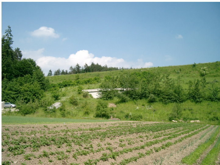
Slika 5.39 Končni izgled severnega dela brežine nasipa na območju profilov P70 do P80 (pogled iz naselja Bizovik)
