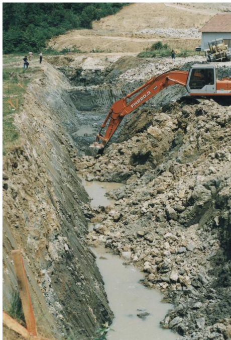
Slika 5.9 Izkop temeljne pete pod nasipom na območju profilov P70 do P80
