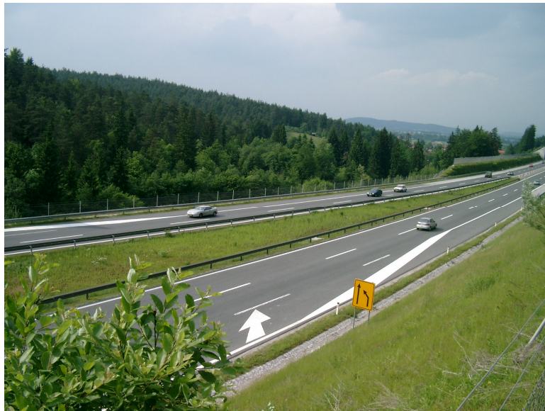
Slika 5.44 Končni izgled nasipa na območju profilov P100 do P114 (pogled iz AC)
