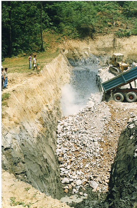
Slika 5.13 Vsipanje gruščnatega materiala za vgradnjo v temeljno peto pod nasipom na območju profilov P56 do P60
