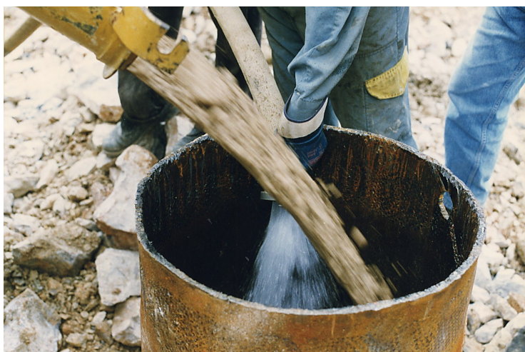
Slika 5.17 Z vgrajevanjem polno zasičenega gruščnatega materiala je bilo preprečeno stiskanje vgrajenega gruščnatega materiala zaradi pritiskov vode v tleh
