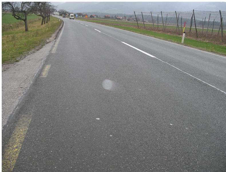
Slika 14: Odsek R2-447/0290 Šentrupert - Ločica: testni odsek 2
