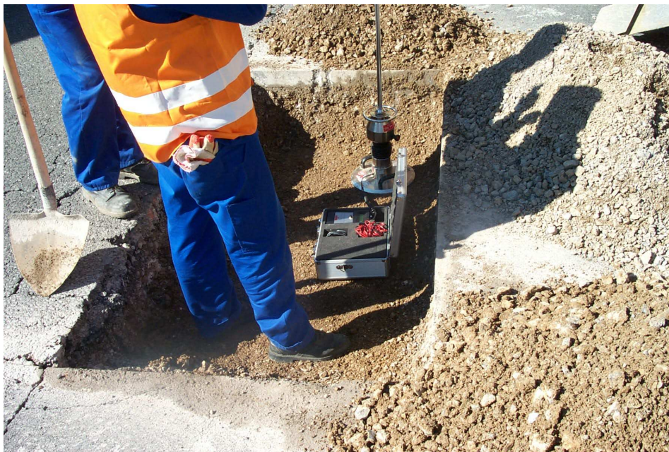
Slika 1: Izvedba meritev nosilnosti podlage z dinamično ploščo
