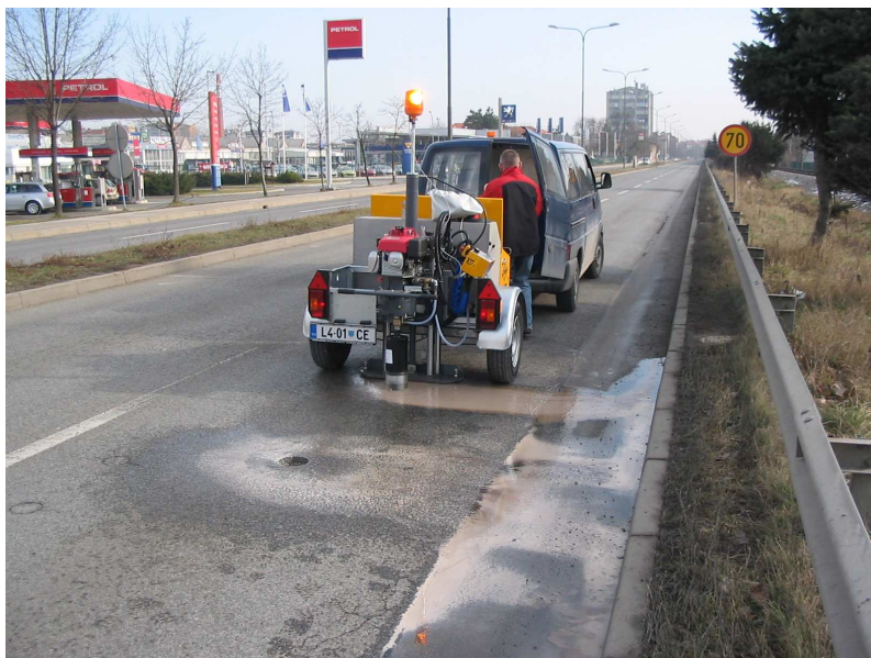
Slika 8: Odvzem asfaltnih jeder na testnem odseku
