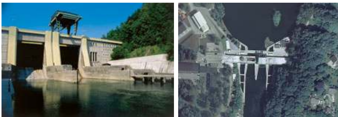
Slika 10. HE Medvode - pogled (levo) in digitalni orto-foto (desno). Figure 10. The Medvode Hydropower station.
