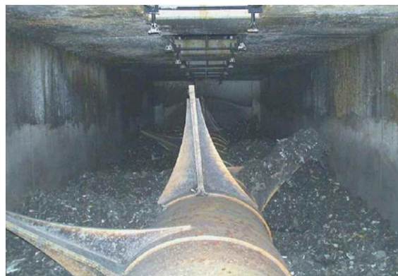
Slika: Notranjost precejalnika (Rettenberger, 2007)
