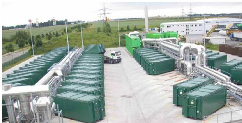
Slika : Bio-sušenje v kontejnerjih in biofilter v ozadju (Breuer, 2007)
