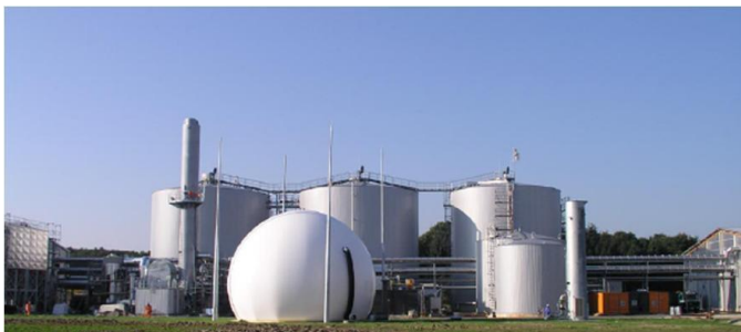
Slika: Fermentorji, rezervoar bioplina in RTO naprava (Sieksmeyer, Stockinger, 2008)
