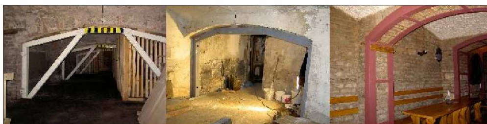
Fotografije zgoraj : Začasna ojačitev konstrukcije objektov nad traso predora (vir: Butovič, 2004)
