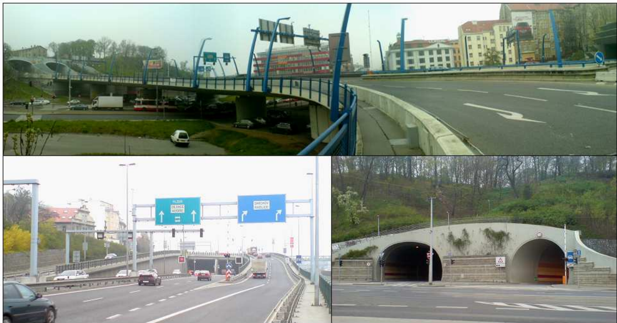
Fotografija 1 (zgoraj): Mozartov most. Levo južni portal predora Strahov, skrajno desno pa severni portal predora Mrazovka. Fotografija 2 (spodaj levo): Južni portal predora Mrazovka. Fotografija 3 (spodaj desno): jugovzhodni portal predora Mrazovka, priključek na Radlicko cesto (foto: avtor, 2008)
