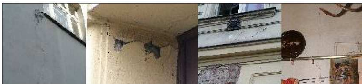
Fotografije zgoraj: Razpoke na objektih kot posledica izkopa predora Mrazovka (vir: Butovič, 2004)
