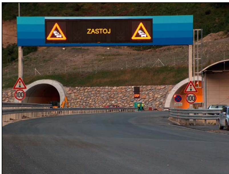
Slika 3-5: Grafični prikazovalnik spremenljive prometno-informativne signalizacije (SPIS)
