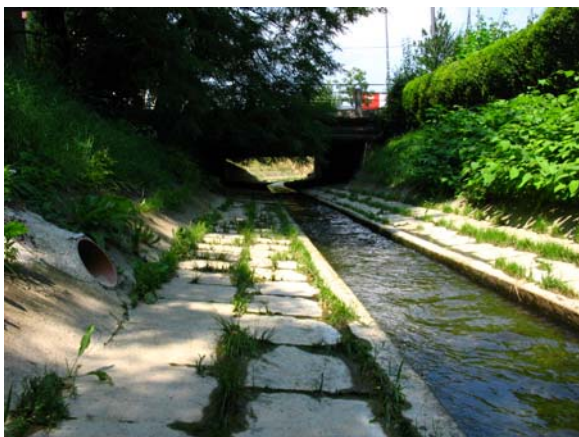
Slika 4.25: Vzorčno mesto GLIN 5 dne 15. 7. 2005, pogled gorvodno
