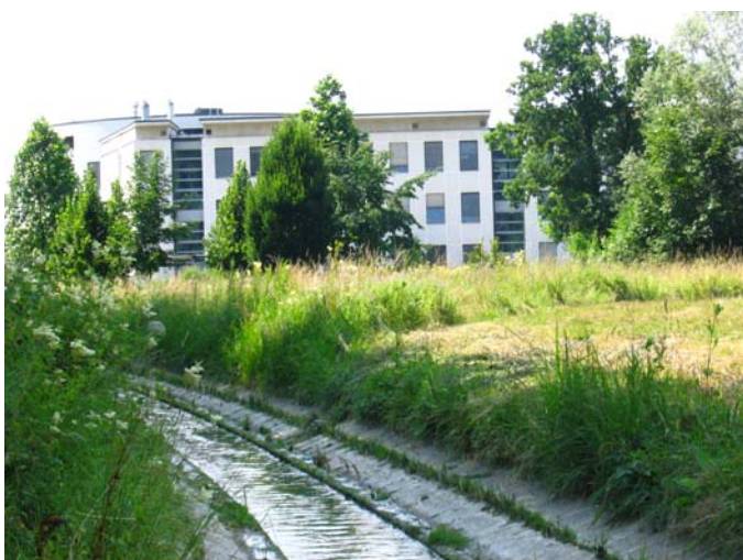
Slika 4.20: Vzorčno mesto GLIN 4 dne 15. 7. 2005, pogled gorvodno
