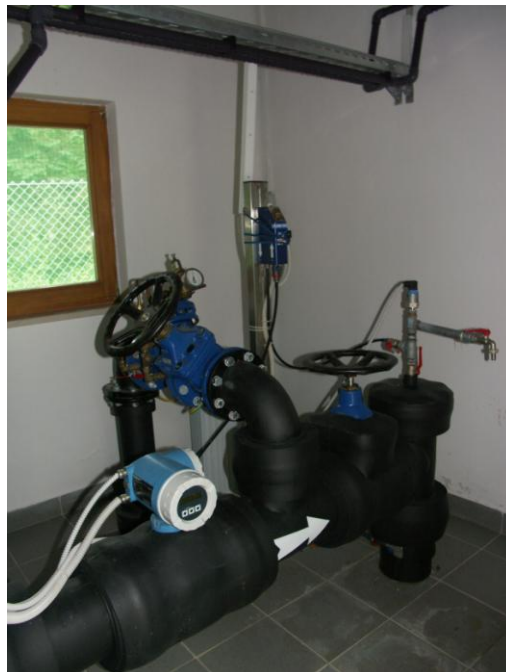
Slika 8: Črpališče Vodice - notranjost
