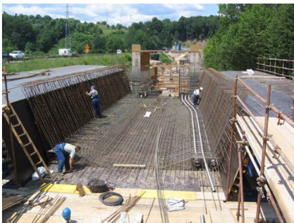
SLIKA 37: Polaganje armature spodnje plošče ter sten
