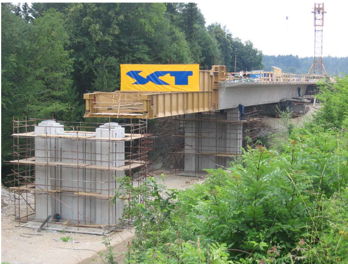
SLIKA 8: Kljun prekladne konstrukcije
