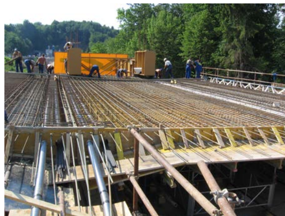
SLIKA 38: Polaganje armature zgornje plošče
