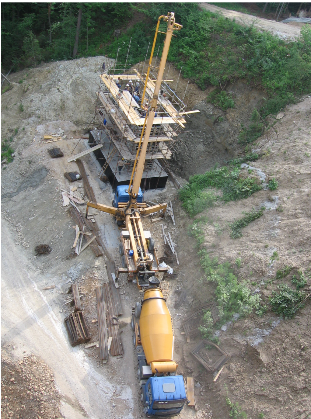
SLIKA 36: Betoniranje enega izmed stebrov podporne konstrukcije
