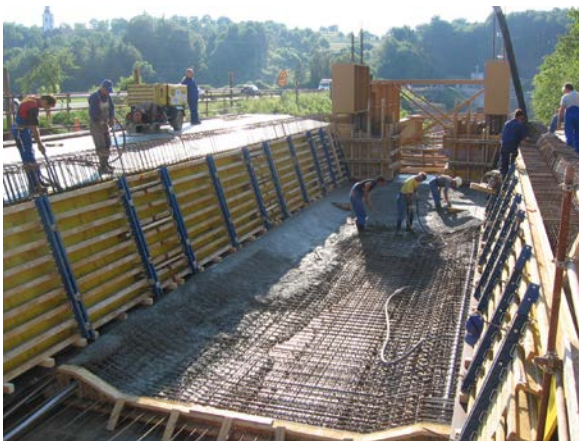
SLIKA 32: Betoniranje spodnje plošče ter sten
