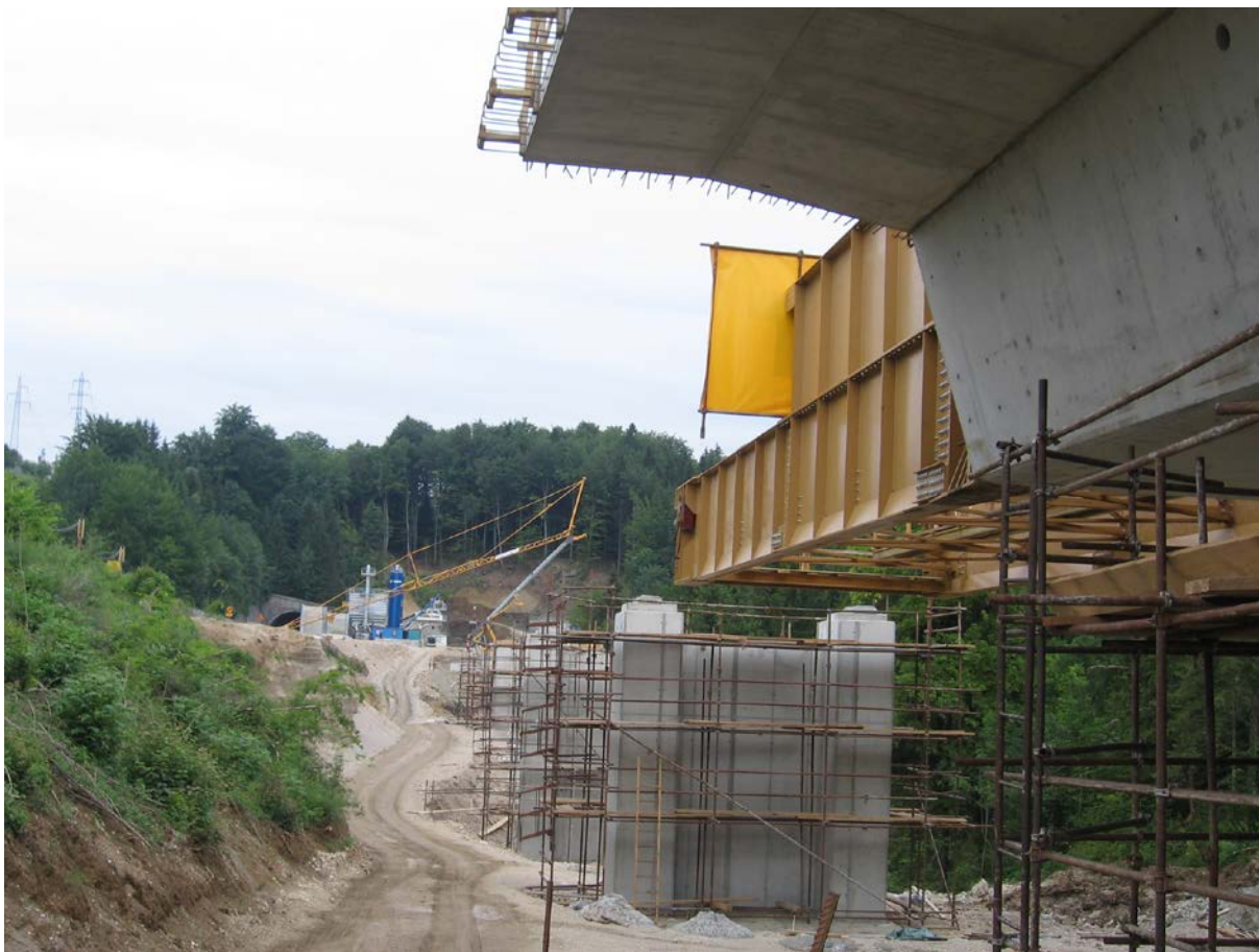
SLIKA 1: Gradnja viadukta Ljubno s tehnologijo postopnega narivanja
