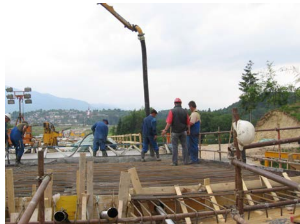
SLIKA 33: Betoniranje zgornje plošče
