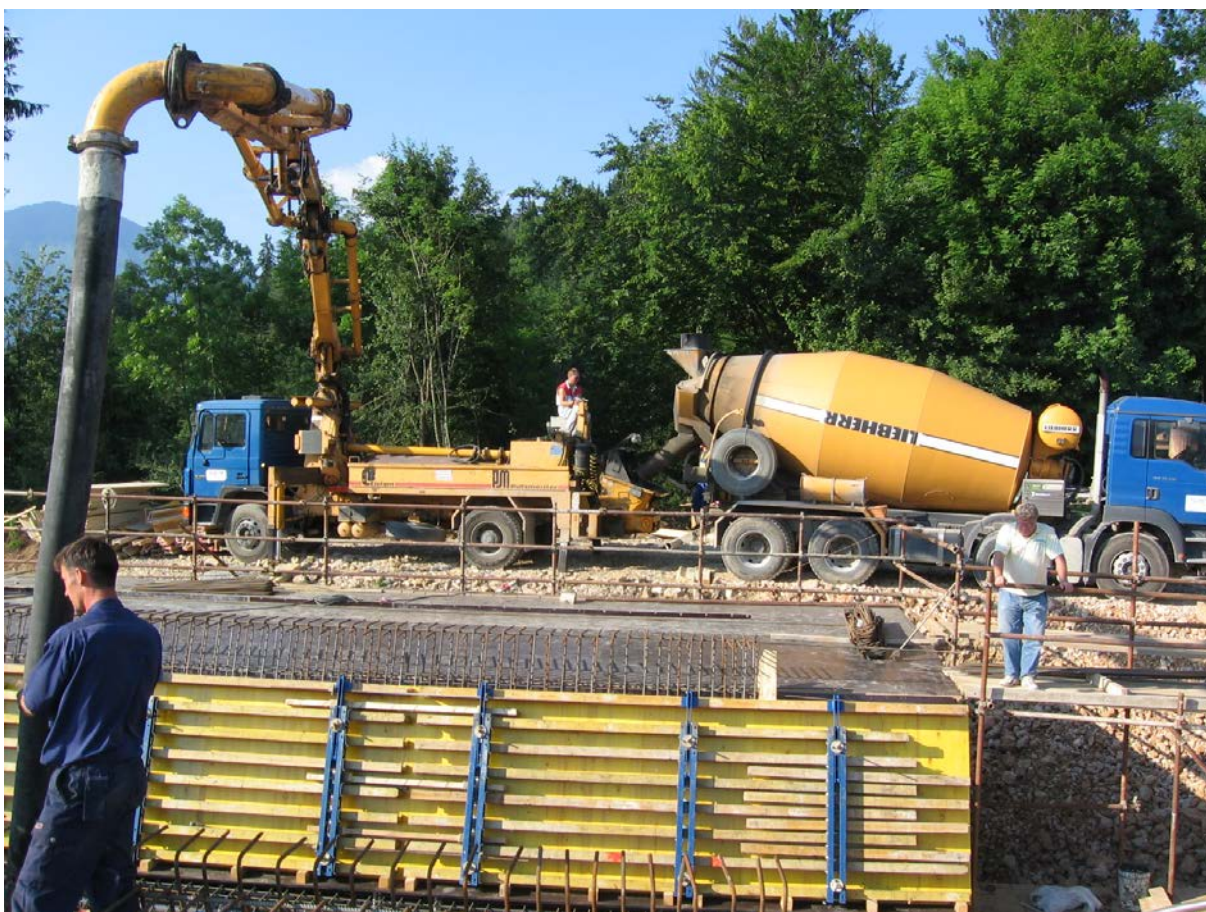
SLIKA 31: Betoniranje s pomočjo črpalke za beton preko avtomešalca
