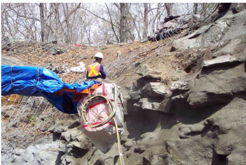
Fotografija 8: Nanašanje brizganega betona (Janod, 2006).
