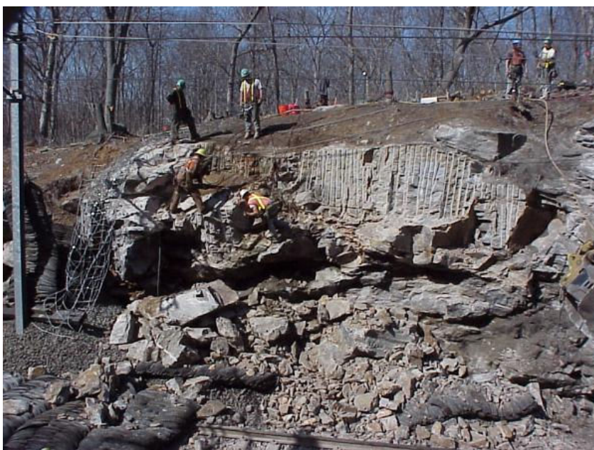
Fotografija 10: Razstreljevanje nestabilnih delov (Vertec, 2006).
