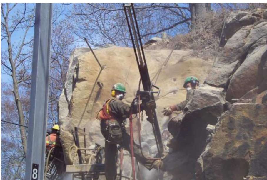
Fotografija 7: Vgrajevanje sider (Janod, 2006).
