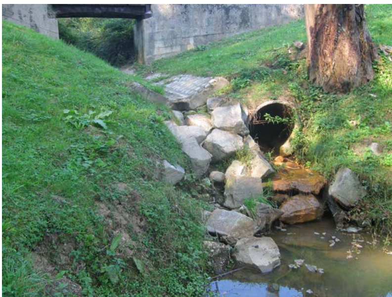
Slika 8: Iztok meteorne kanalizacije v drugi ribnik. Dotok Ribniškega potoka je zaradi sušnega obdobja na sliki suh.
