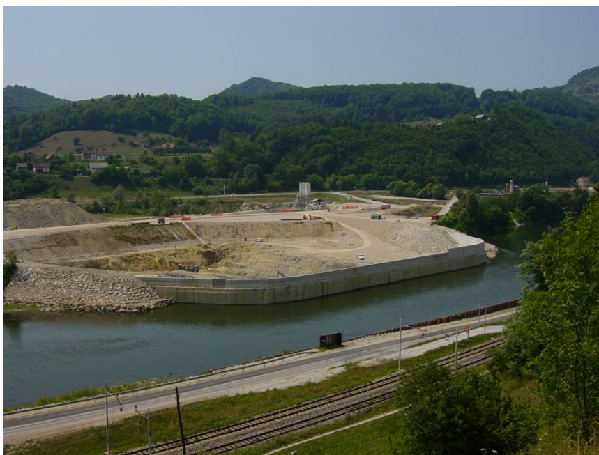
Slika 18: Gradbena jama HE Boštanj.
