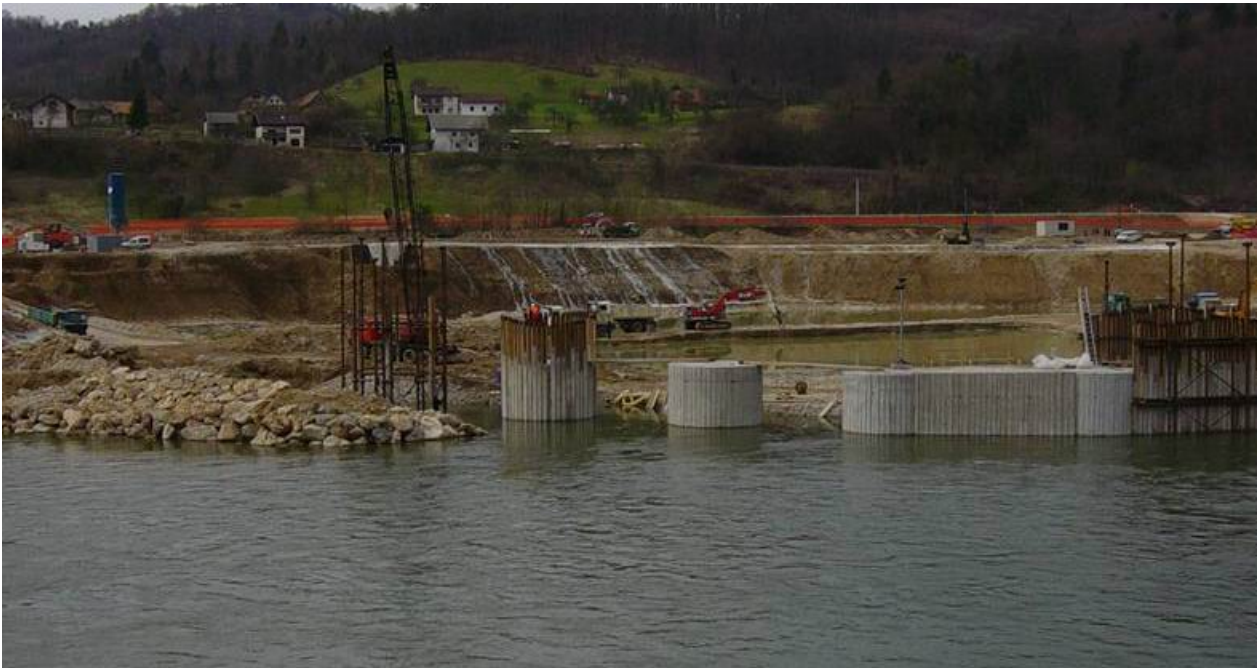
Slika 20: Potek gradnje obodnih sten gradbene jame.
