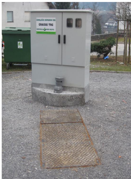
Slika 19: Končni videz poliestrskega črpališča na gradbišču v Žužemberku
