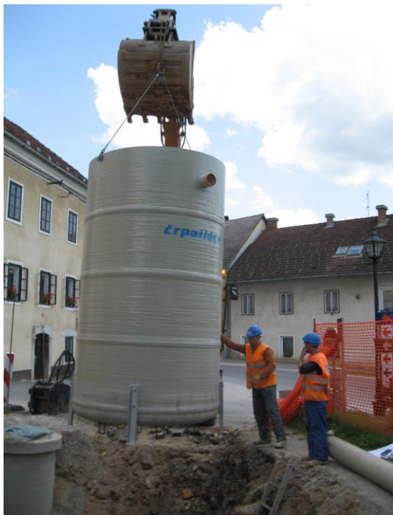
Slika 18: Vgradnja poliestrskega črpališča fi 2000 x 3600 mm, Regeneracija na gradbišču v Žužemberku
