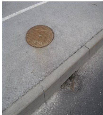
Slika 13: Betonski cestni požiralnik Ø 50 cm pod pločnikom s peskolovom
