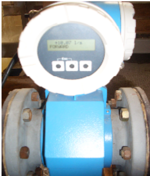
Slika 21: Elektromagnetni merilec pretoka Promag 50W
