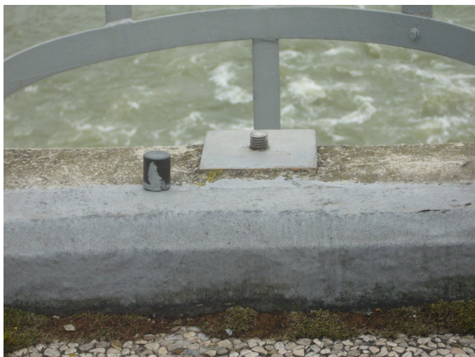
Slika 4: Stabilizacija kontrolne točke H6
