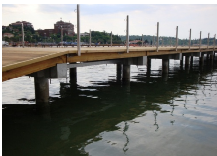
Slika 40a: Obnovljeni leseni pomol.
