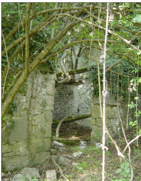
Slika 13 : Težko dostopen in že desetletja opuščen objekt v zaselku Breščina
