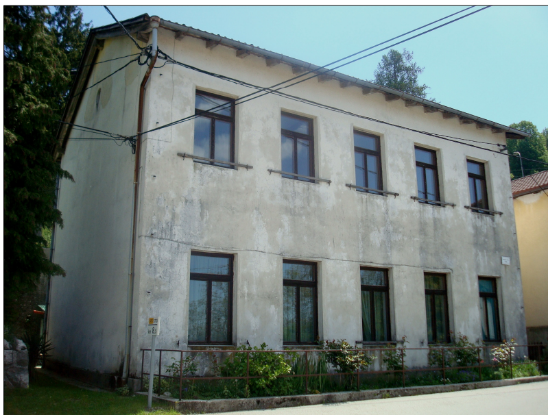
Slika 12: Predmet prenove je objekt bivše podružnične osnovne šole
