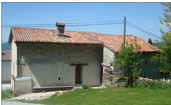
Slika 8: Prenovljen stanovanjski objekt
