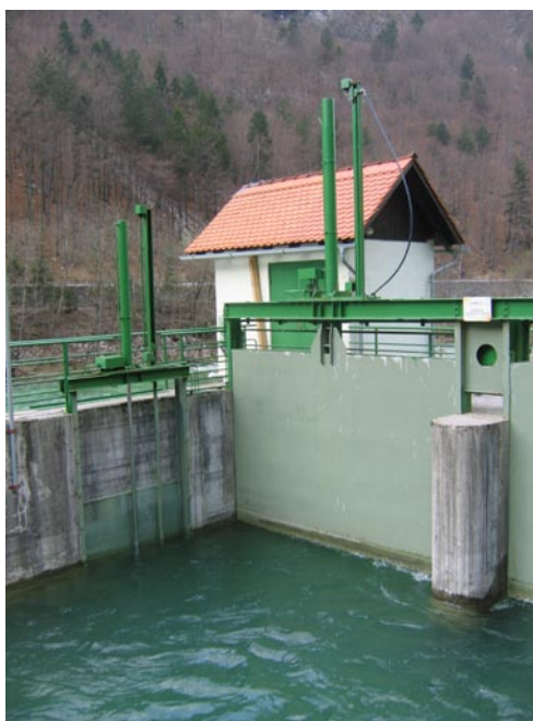
Slika 5.11: Tablasta drsna zapornica( HE Soteska)
