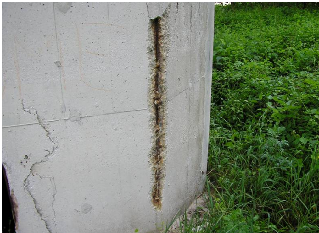
Slika 97: Obstoječe stanje stebrov viadukta Ravbarkomanda
