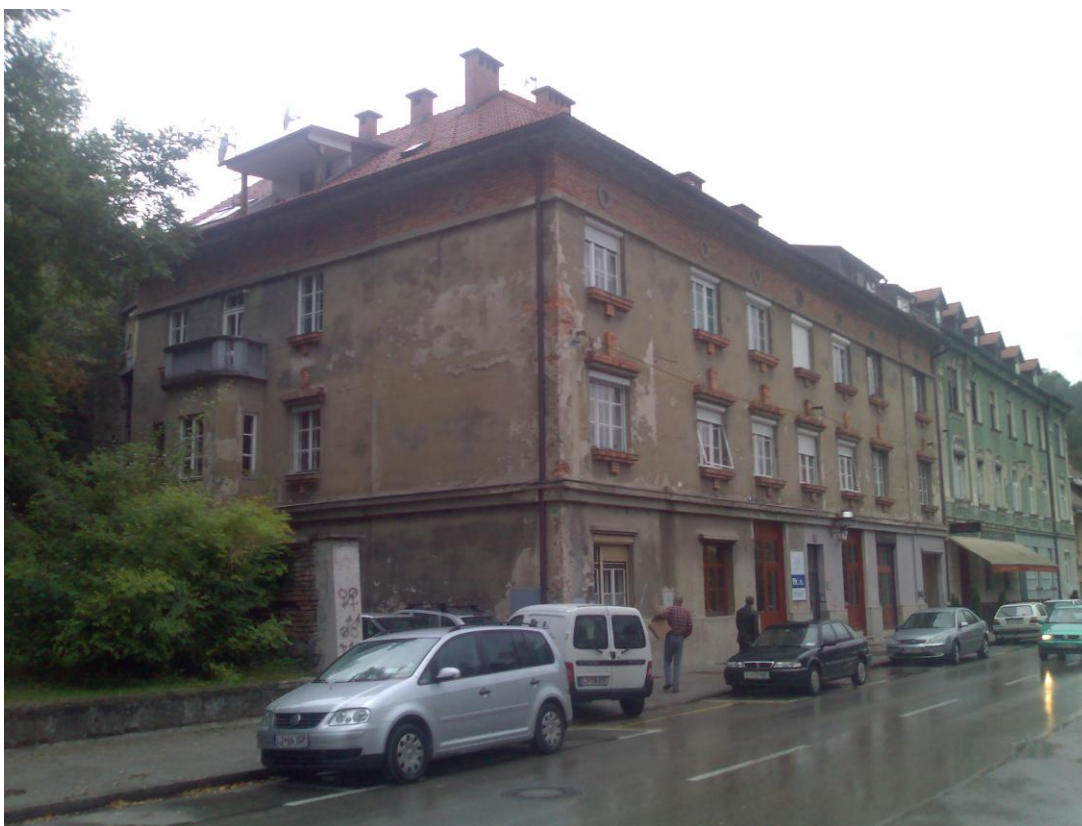
Slika 8: Fasada pred začetkom del
