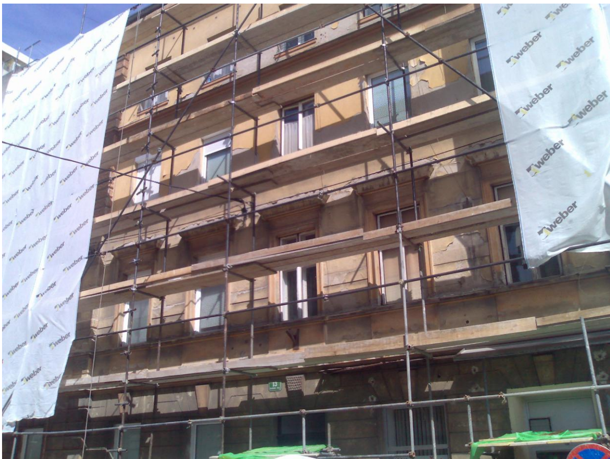
Slika 12: Izgled fasade pred začetkom del
