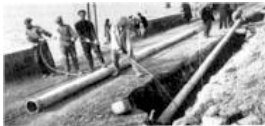
GRADNJA VODOVODA MED KOPROM IN IZOLO
