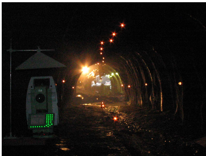
Slika 1: Geodetska opazovanja obnašanja predora med njegovo izgradnjo [foto: J. Klopčič]
