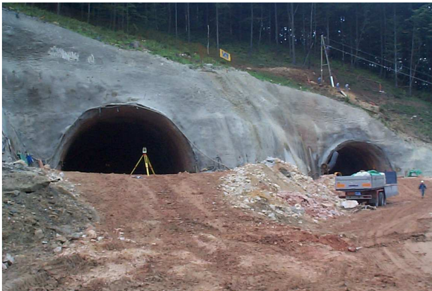
Slika 4: Situacija na gradbišču [foto: J. Klopčič]
